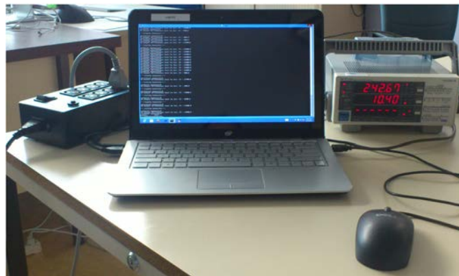
FIGURE 3.7 – Installation de l'Ultrabook avec le Yokogawa WT210
