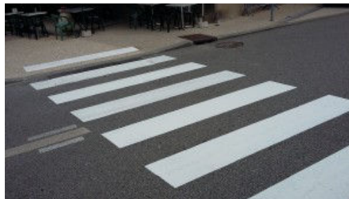
(a) Passage piéton
