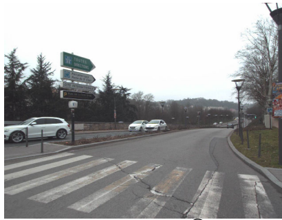
FIGURE 2.3 – Exemple d'une image VIAPIX ® de taille 1216 × 1600 pixels illustrant un passage piéton détérioré.
