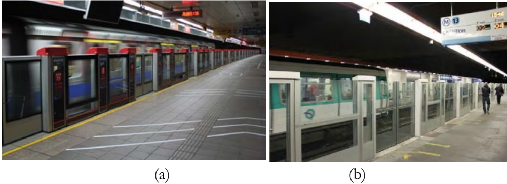
Figure 35. Portes palières automatiques (a) 11 Métro de Taipei (b) 12 Métro de Paris ligne 13
