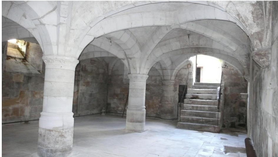
Salle souterraine du manoir de Bévilliers 2
