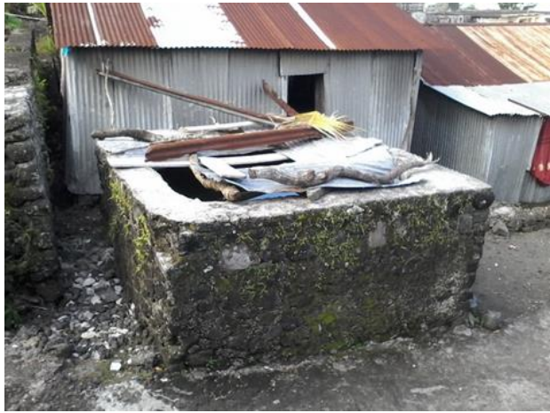
Photographie 26 : Citerne avec gouttière en tôle en dehors du ménage à Hassendje à la Grande Comore
