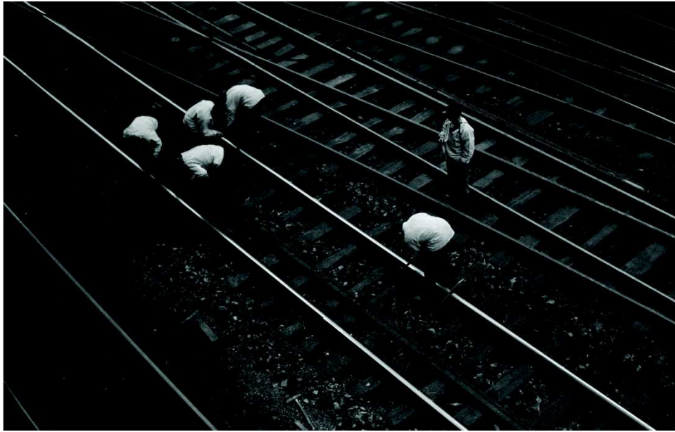
Ouvriers au travail sur les voies de circulation
