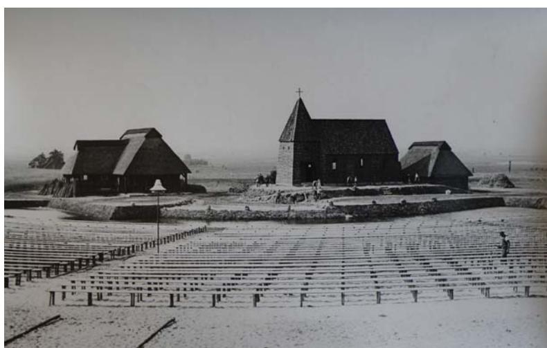
125. Le chantier du théâtre de Stedingsehre , Bookholzberg, autour de 1935
