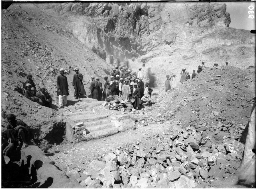
La chapelle de Séthi I er durant son déblayage ( SABAP-TO, archivio fotografico, C 930 )
