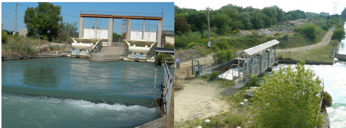
FIGURE 5.9 – Photographie de l'architecture hydraulique au partiteur des Crottes. Photographie de gauche, au fond : module à masque permettant une régulation « à niveau aval constant » du canal. Photographie de gauche, au premier plan et photographie de droite au fond à droite, « palette » installée par les irrigants selon le fonctionnement de la « prise d'eau ». Photographie de droite, à gauche ouvrage d'alimentation du canal des Alpines avec écoulement souterrain pour rejoindre le canal. Sources : http://contratdecanalcrasudalpilles.over-blog.com/ consulté le 05/09/16.
