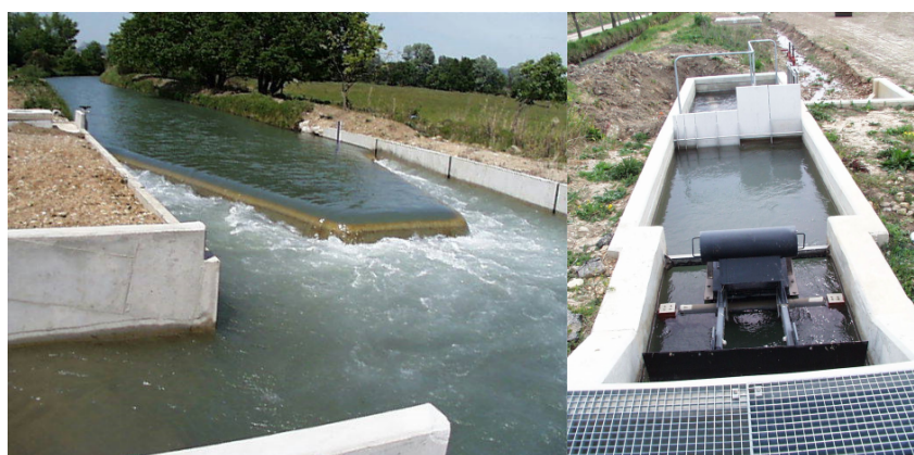
FIGURE 5.12 – . « Seuil « bec de canard » » et « Prise de tête (vanne AVIO et modules à masque) » Sources : http://www.canari.free.fr/photos/ph_merl.htm consulté le 05/09/16. Auteur : Gilles Beaud (professeur hydraulique SupAgro)
