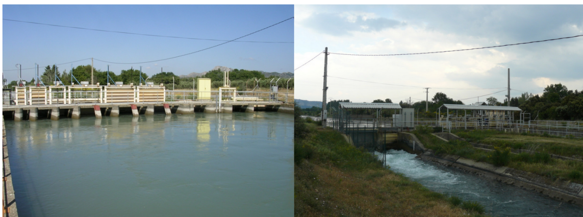
FIGURE 5.10 – Architecture hydraulique au partiteur d'Eyguières. Photographie de gauche, vue de l'ouvrage depuis l'amont (canal commun UBC). Photographie de droite, vue de l'ouvrage depuis l'aval, alimentation du canal de Craponne et des différents canaux. Sources : http://contratdecanalcrasudalpilles.over-blog.com/ consulté le 05/09/16.
