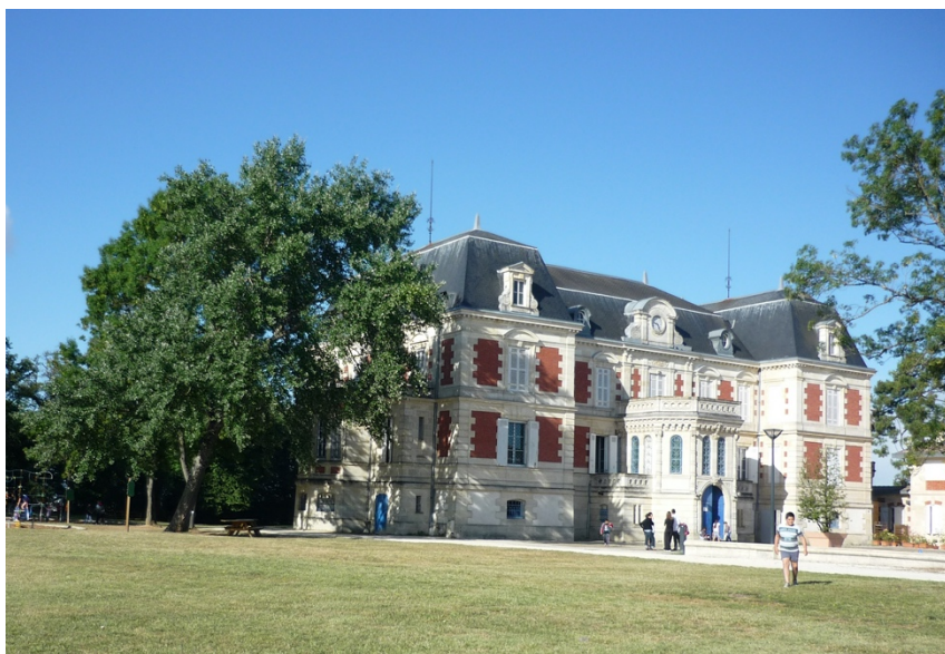
Figure 29. Château des Iris construit en 1864 avec son parc paysager sur la commune de Lormont. Source : Grand Projet des Villes Rive Droite – Juin 2013.
