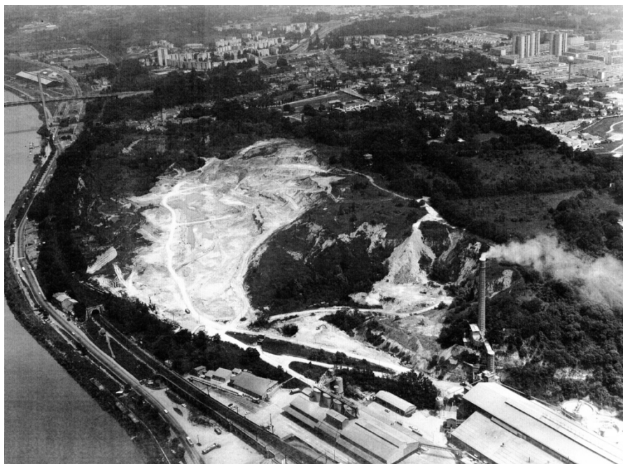
Figure 31. Vue aérienne de la cimenterie Poliet et Chausson – non datée, estimée à la fin des années 1970. Source : Fonds de l'association Les amis du vieux Lormont.
