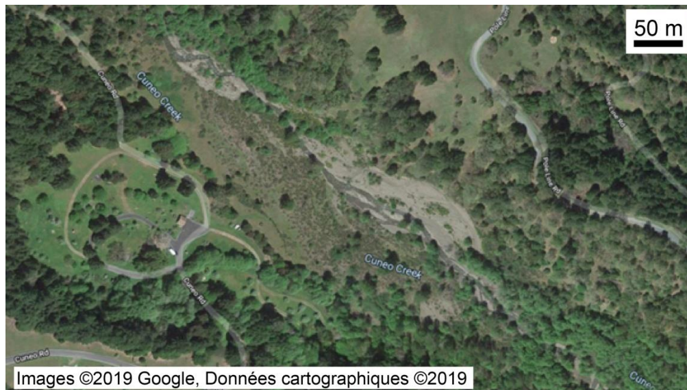
Figure 18. La portion du Cuneo Creek (Californie) restaurée dans les années 1990
