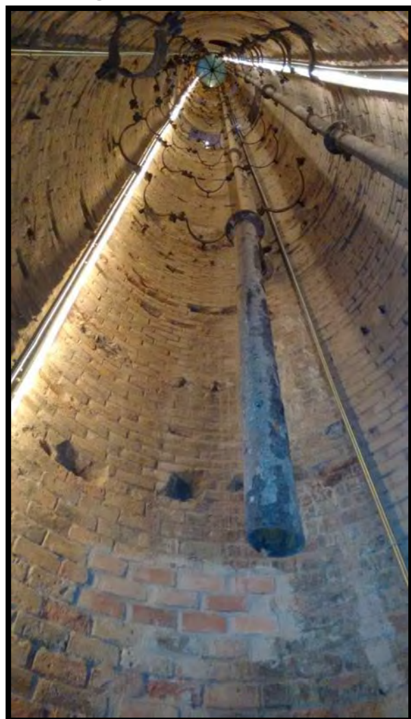
Image 11. L'intérieur de la tour
