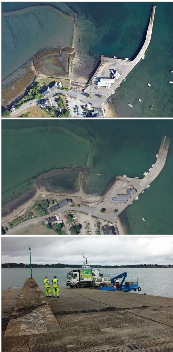
Figure 154 – Elargissement de la cale de Béluré.
