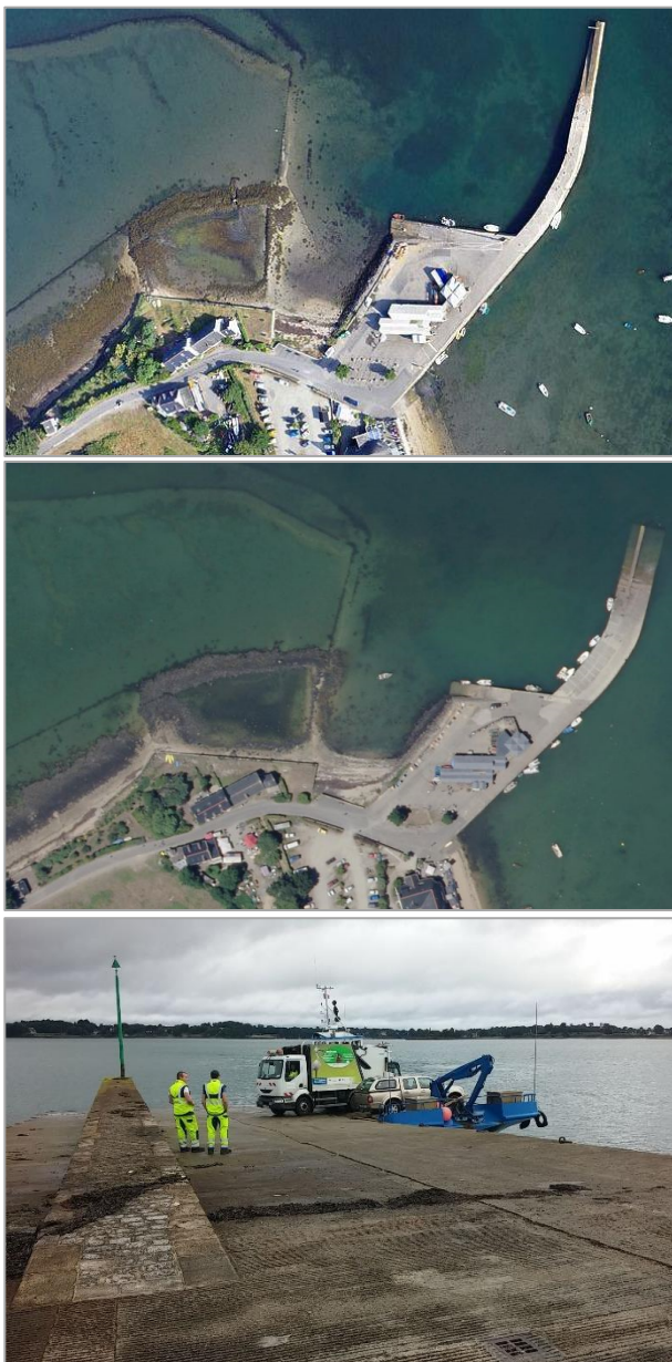
Figure 154 – Elargissement de la cale de Béluré.
