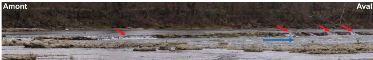
Figure 3.4 : Photo du seuil en période de hautes eaux moyennes. La flèche bleue représente la direction d'écoulement principal du chenal central et le sens de l'écoulement. Les flèches rouges représentent l'écoulement oblique par rapport au chenal central lors de la mise en eau du seuil pendant une crue. Ainsi se forment des rapides entraînant un affouillement de la bordure du seuil (Fig. 3.3). Le débit au moment de la prise de vue est de 117 \text{ m}^3 \cdot \text{s}^{-1} à la station de Portet-sur-Garonne.
