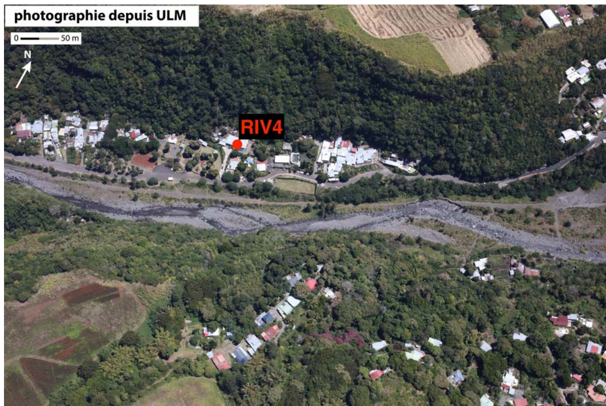
Figure 31. Exemple d'une image obtenue dans la zone de la station RIV4 (Rivière des Pluies) à partir des photographies aériennes (ULM).
