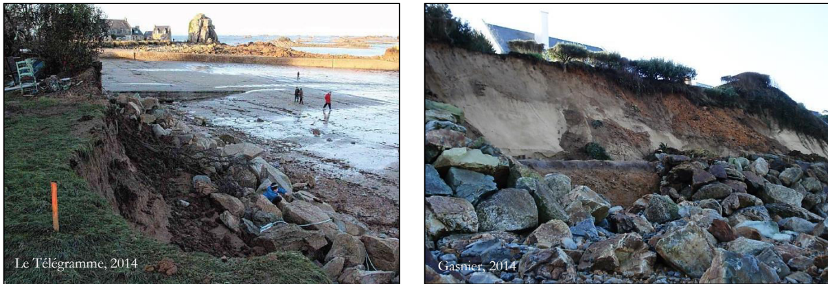
Fig. 241 : Enrochements détruits à la suite des tempêtes de février 2014 et érosion des terrains en arrière, sur le site de Pors-Hir, à Plougrescant (photo de gauche) et au Moulin de la Rive, à Locquirec (photo de droite).
