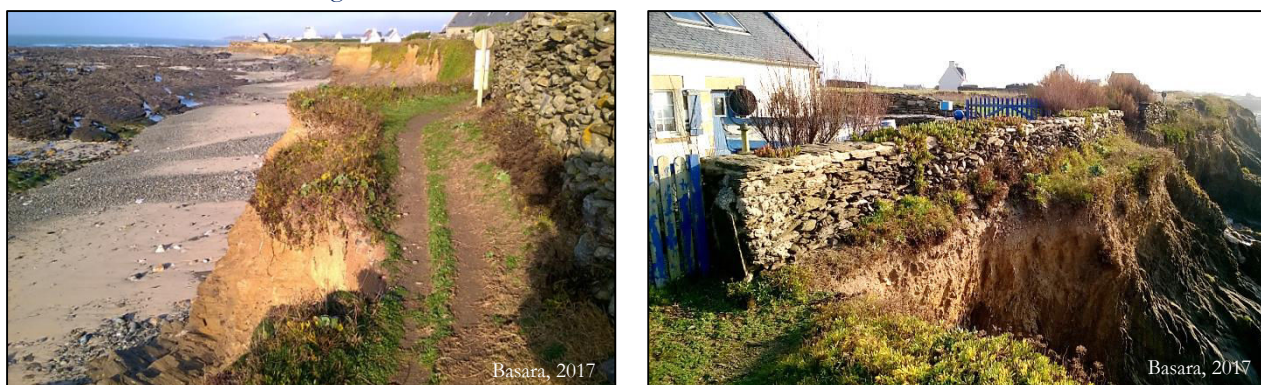
Fig. 217 : Érosion du sentier côtier de Poulbréhen à Plozévet.
