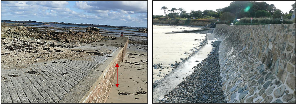
A : Grande cale de mise à l'eau (la flèche montre la différence d'altitude de la plage entre le flanc sud et le flanc nord de la cale) ; B : Perré surmonté d'un parapet.
