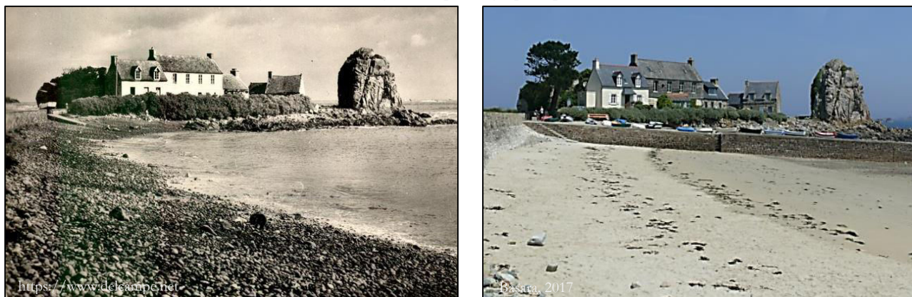
Fig. 113 : Disparition des galets de l'anse de Pors-Hir. À droite, photographie datant d'avant la construction de la grande cale et à gauche, photographie prise en 2017.
