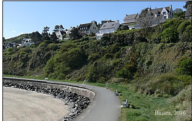
Digue-promenade et drainage du versant (Plérin, 22)
