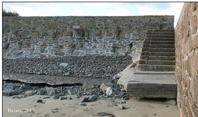
Fig. 155 : Démaigrissement du haut de plage à Pors-Hir, à l'automne 2017, visible par le déchaussement des ouvrages.
