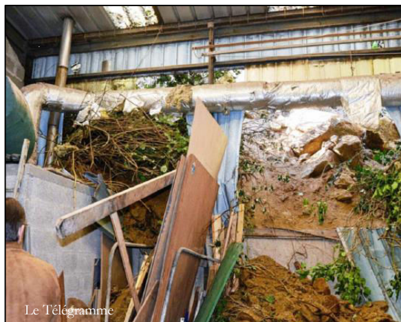
Photo de gauche : éboulement de falaise détruisant une partie de la façade arrière du centre nautique à Douarnenez (11/02/2014); Photo de droite : glissement de versant coupant l'accès à une route départementale à Plestin-les-Grèves (14/02/2014).
