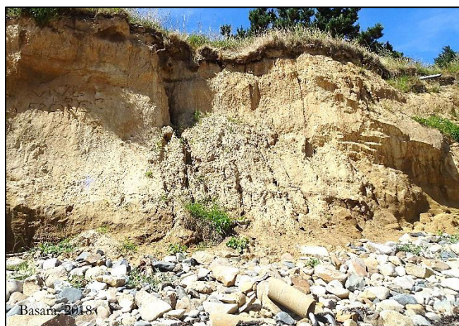
Fig. 245 : Buse d'évacuation des eaux, visible sur le site de Pors-Hir à Plougrescant, et incisant la falaise par le déversement des eaux.
