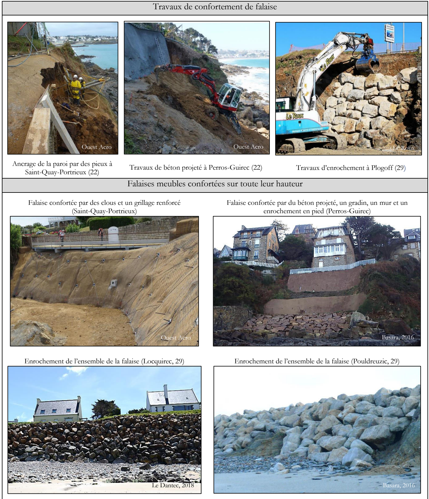
Fig. 39 : Techniques de durcification du front de falaise utilisées en Bretagne.
