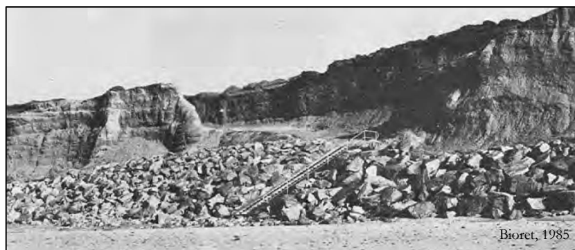
Fig. 15 : Enrochement mis en place au pied des falaises meubles de la Mine d'Or à Pénestin, dans les années 1970.
