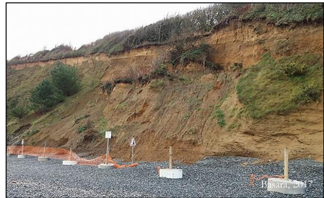
Filet installé en pied de falaise devant un glissement récent et panneau d'avertissement (Plérin, 22)
