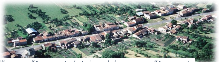
Village-rue d'Arrancourt, photo issue de la commune d'Arrancourt
