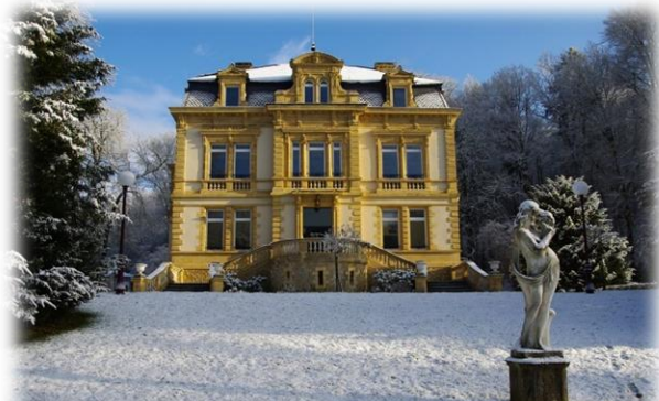
Château bâti en 1887 pour G. R., créateur (en 1872) et propriétaire des Hauts-fourneaux de Zolnes, photo de la commune de Zolnes
