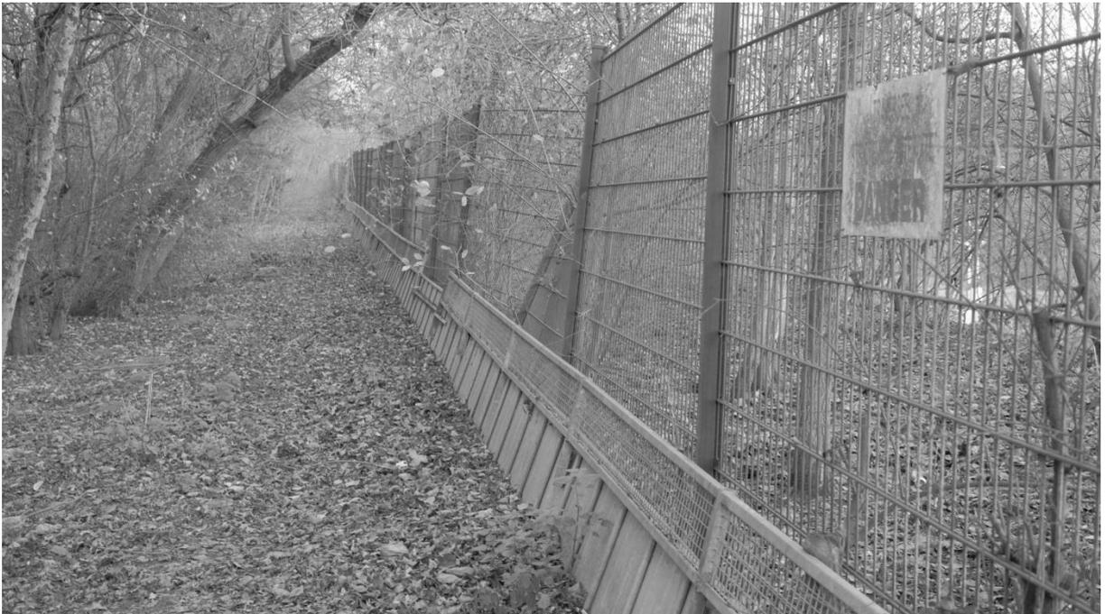
Figure 17 : Dispositif de cloisonnement des voies de chemin de fer à l'aide de palplanches, Parc du Sausset , © Léo.Martin.
