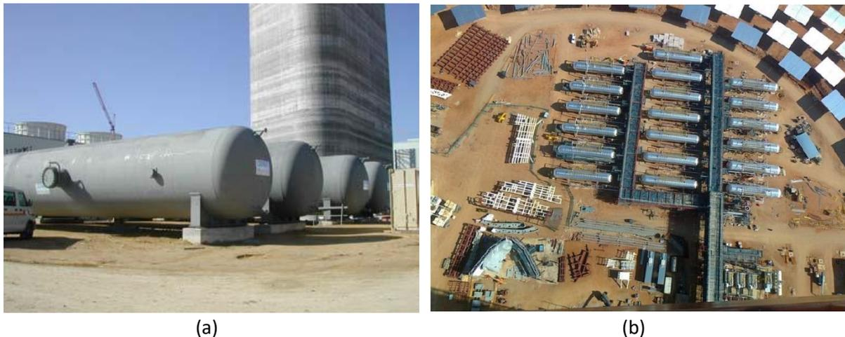
Figure 4 : (a) : Les 4 accumulateurs de Ruths de la centrale solaire PS-10 (Séville, Espagne) [35]
