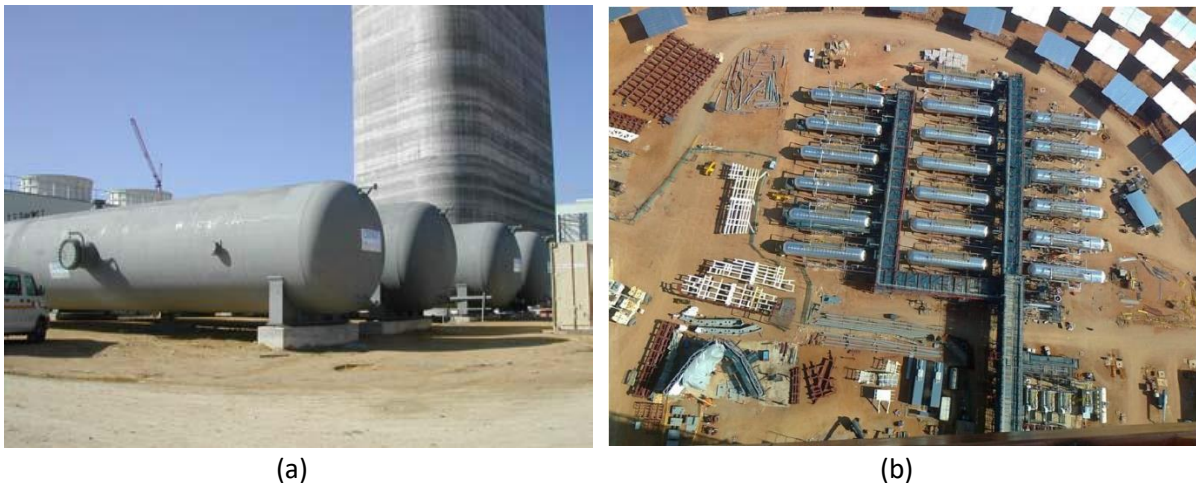
Figure 4 : (a) : Les 4 accumulateurs de Ruths de la centrale solaire PS-10 (Séville, Espagne) [35] (b) : Les 19 accumulateurs de Ruths de la centrale Khi Solar One (Upington, Afrique du Sud) [39]
