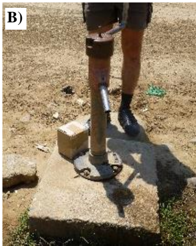
Figure I.24 : Photos illustrant l'accès aux eaux souterraines à Potshini. A) Source provenant de l'aquifère multicouche du Beaufort et B) Pompe à main prélevant dans la nappe de l'Ecce
