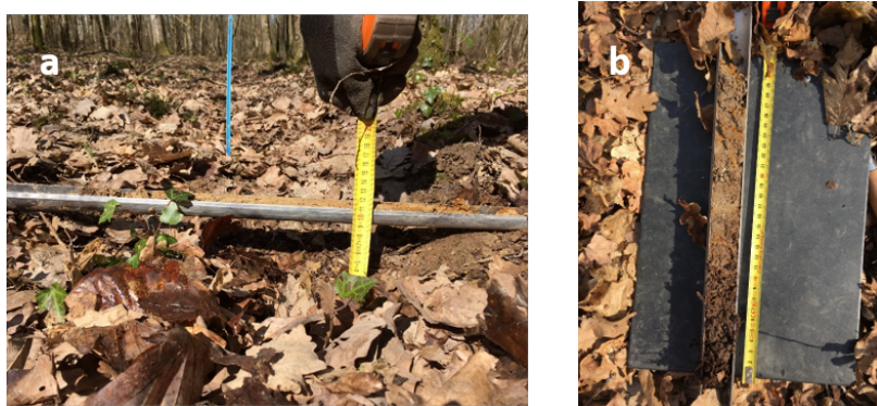
FIGURE 6.12 – Mesures expérimentales réalisées pour définir l'état de dégradation des cloisonnements. (a) Mesure de la profondeur d'ornièrre, (b) Mesure de la profondeur d'apparition des tâches d'hydromorphie.
