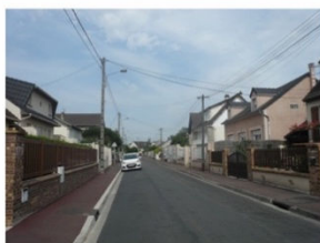
Une rue de banlieue pavillonnaire à Tremblay-en-France (95). Elle fait partie d'une vaste zone urbaine construite à la même époque. Les pylones électriques marquent aussi le paysage.
