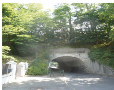
La Celle-Saint-Cloud (78) - Passage sous la voie ferrée
