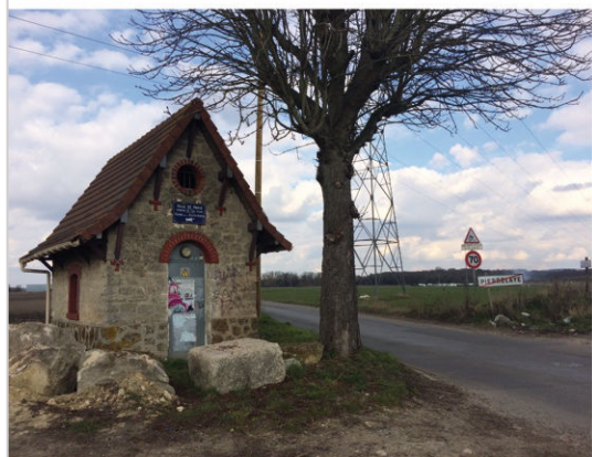
Photographie n°3 : Bâtiment de l'ancien réseau des eaux usées de la Ville de Paris. On distingue au second plan l'aire d'accueil des gens du voyage de la commune de Pierrelaye (Morgane Flégeau, 2016)
