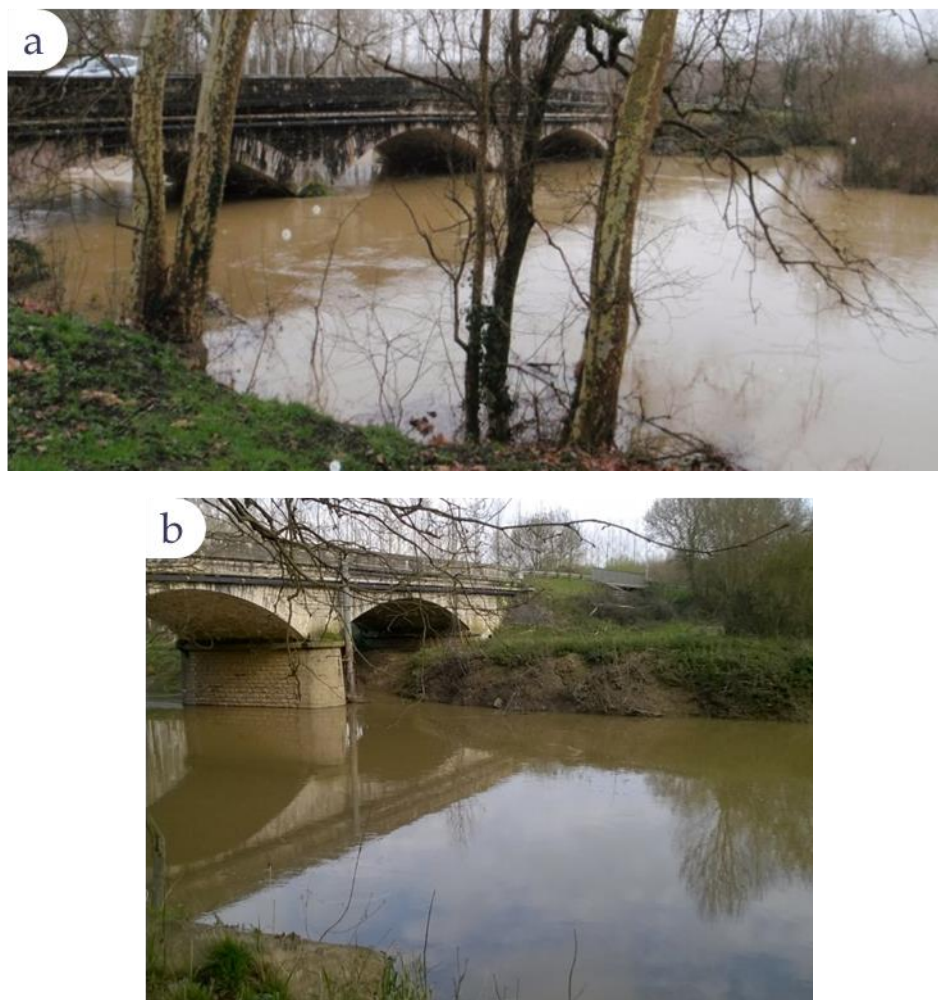
Figure 40 - Le Luy à Saint-Pandélon lors de la première campagne de déploiement : (a) Pose le 07 Mars 2016 ; (b) Récupération le 21 Mars 2016
