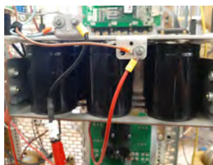
FIGURE D.8 – Condensateur émulant le bus DC du banc PHIL
