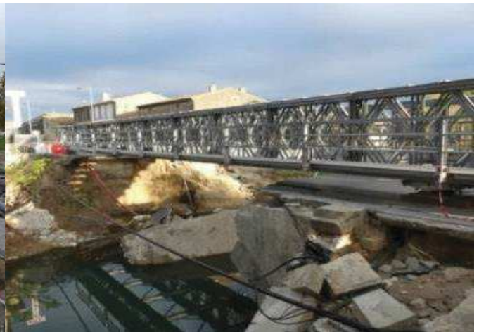
b) Suite à la destruction du pont par le Trapel, travaux de rétablissement de la circulation à l'aide d'un pont provisoire de type Bailey (Villegaihenc - Aude)
