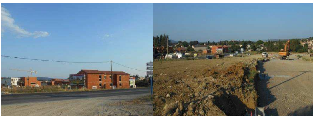
Illustration photographique 3 : Construction de logements et zone de développement urbain en continuité du village (Pignan, Hérault)
