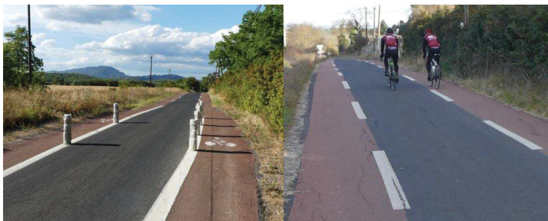
a/ Entrée du dispositif.
