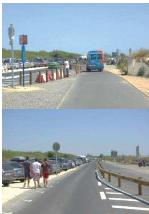
RD 59 en voie réduite à une voie en 2008.
