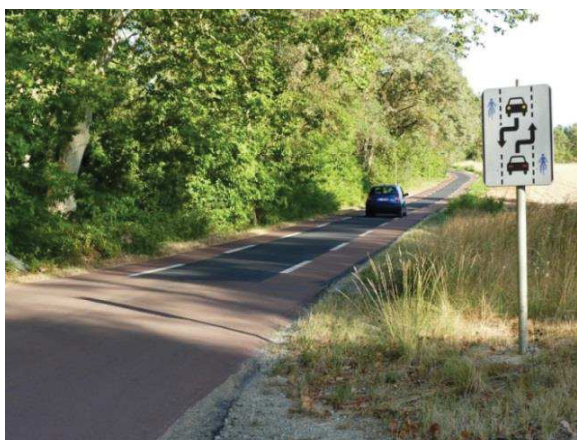
Illustration photographique 15 : Panneau explicatif rappelant le fonctionnement de la CVCB sur la RD112
