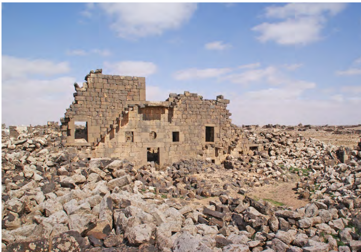
Ph. 220. 'Umm al-Jimāl, Maison XIII. Escalier en façade
