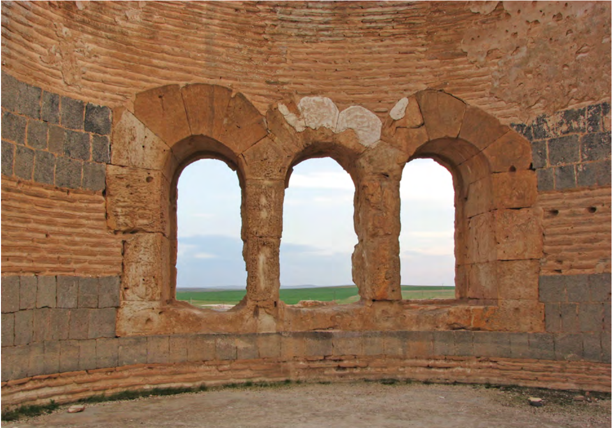
Ph. 182. Qaşr Ibn Wardān. Les fenêtres d'une des absides du triconque
