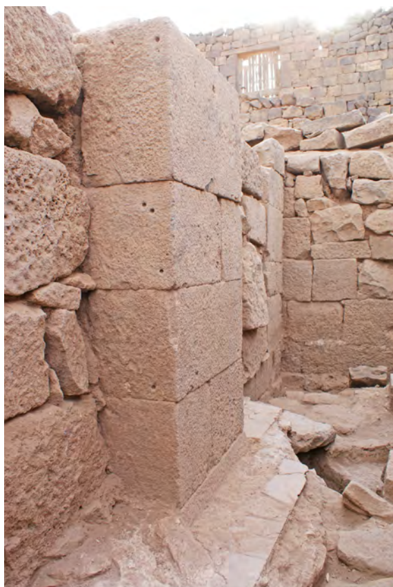
Ph. 94. Les bains. Piédroit d'arc, cavités et agrafe en bronze dans la salle L. 030
