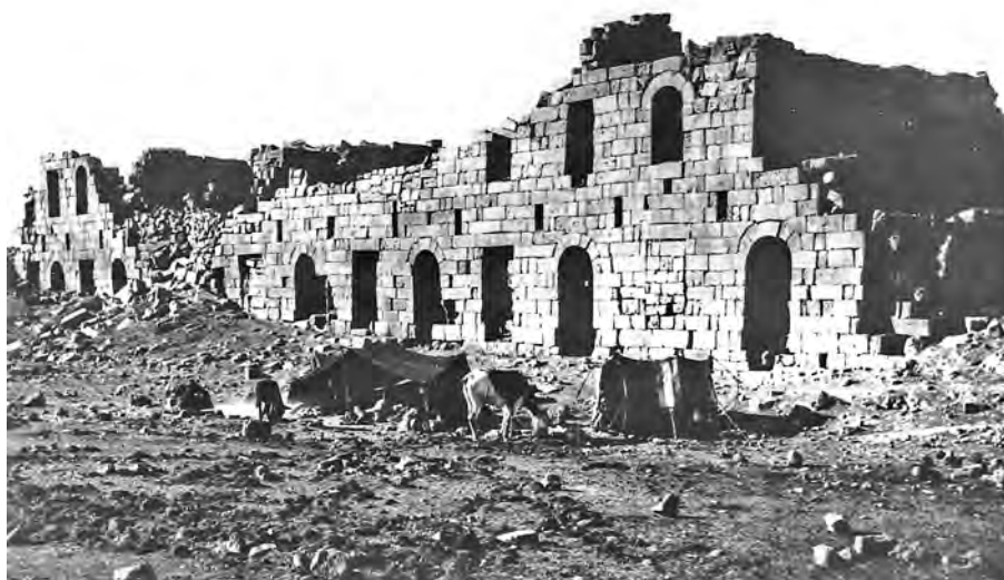
Ph. 68. Le « Palais de Trajan ». Bâtiment est, le mur à niches en 1930 (Fonds d'archives Maurice Dunand)
