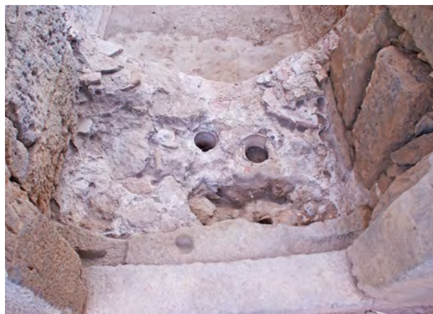
Ph. 123. Les bains. Porte entre L. 035 et L. 007, vers le nord
