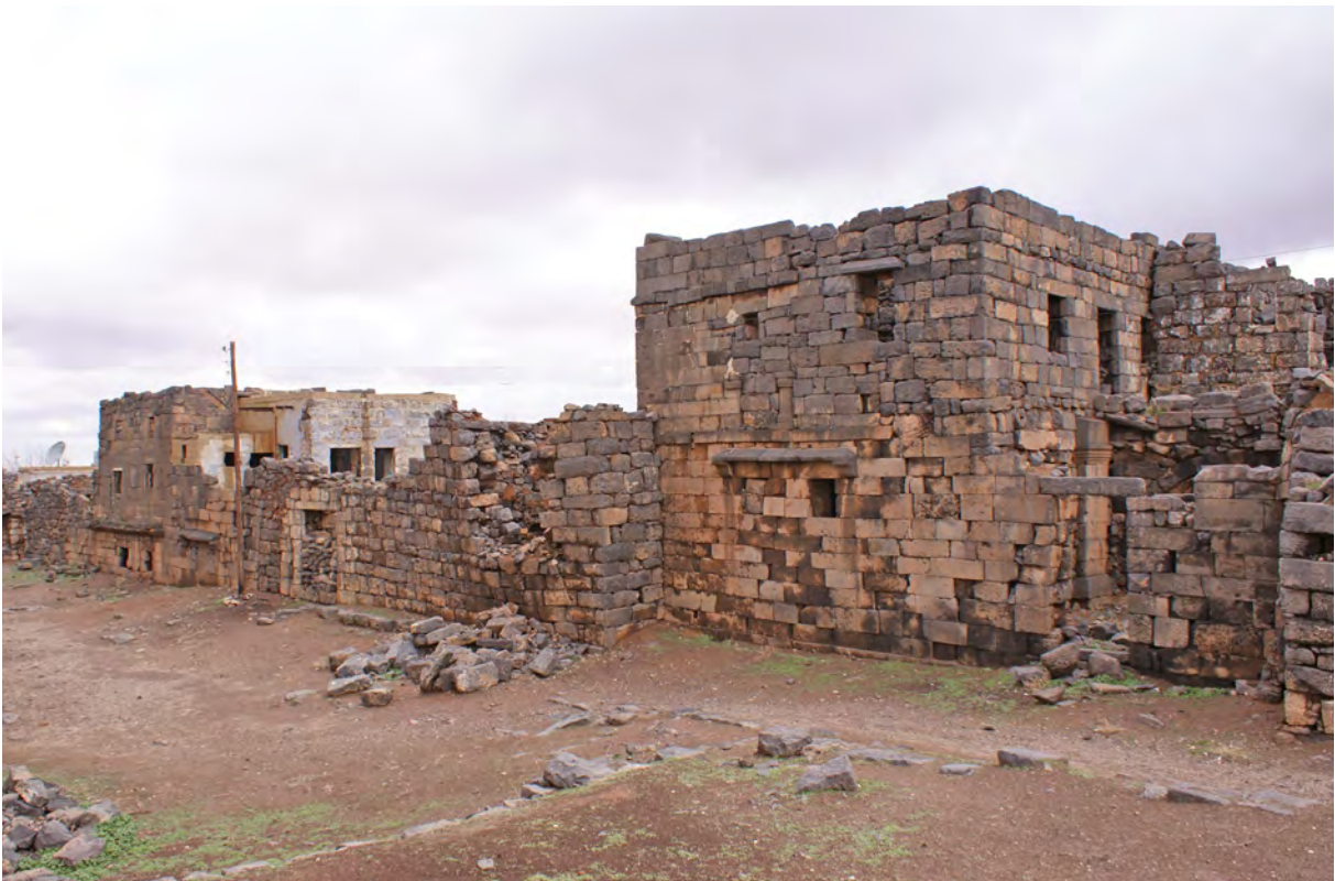
Ph. 12. Bosra, façade de la maison 3
