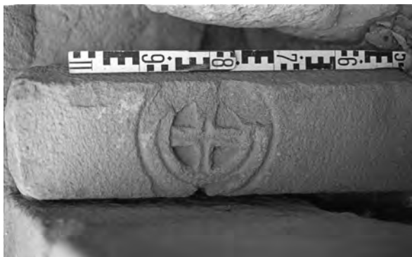
Ph. 176. Le « Palais de Trajan ». Linteau portant une croix (MAFSS 1975)
