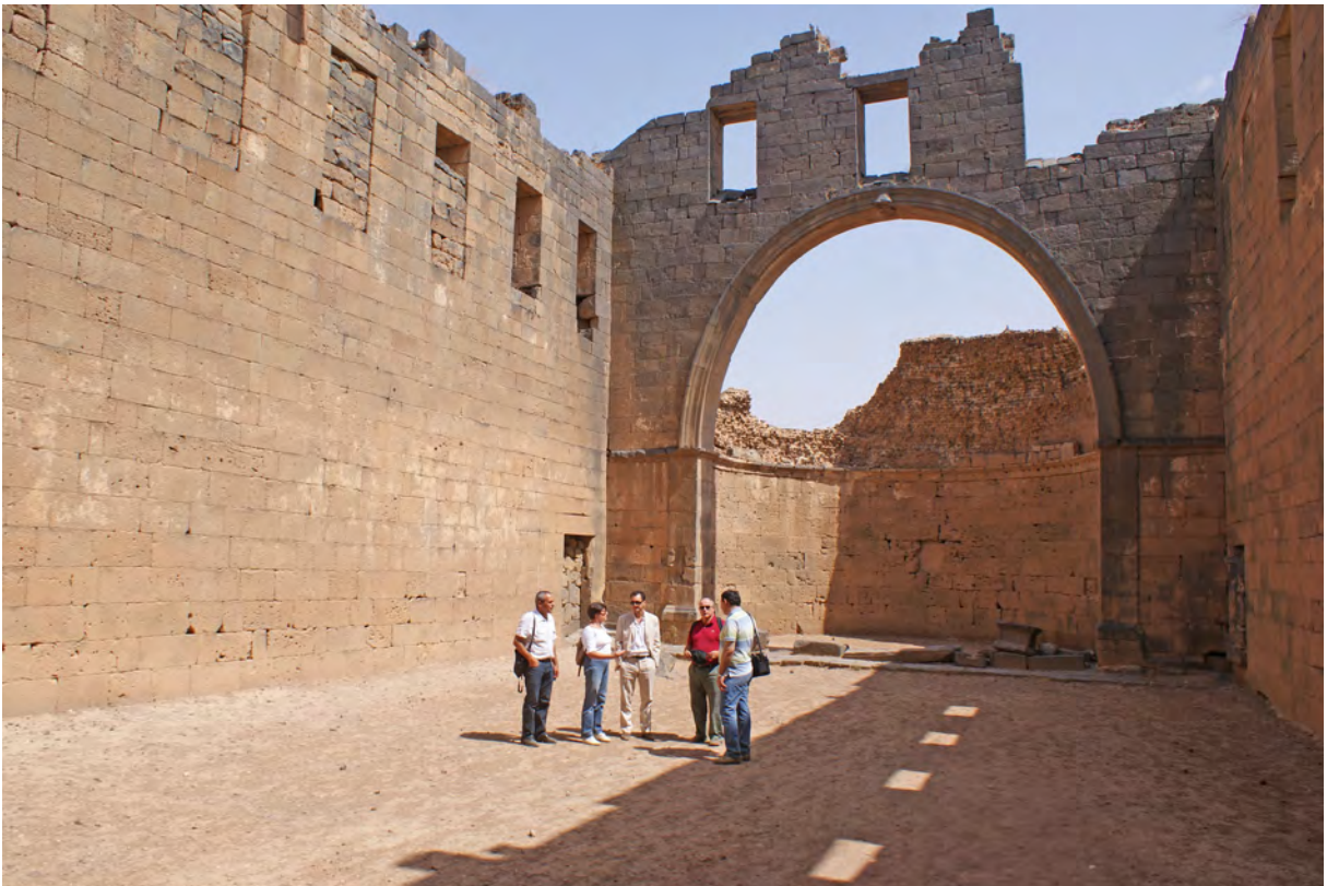
Ph. 200. Bosra. Cul-de-four maçonné de la basilique de Bahīrā. Vues extérieure et intérieure (P. Piraud-Fournet et M. al-Adawi 2009)
