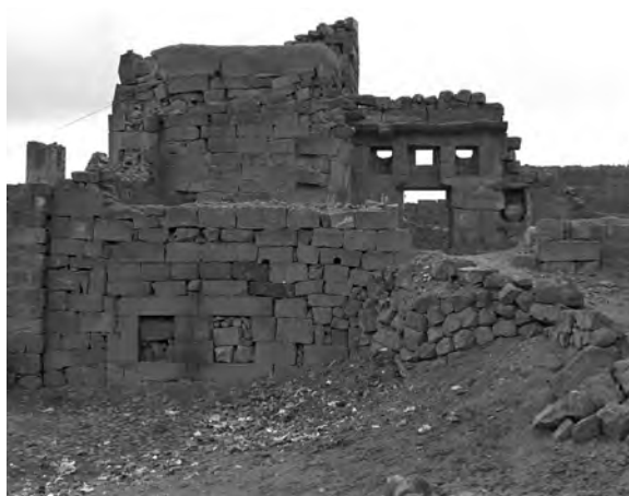
Façade extérieure du bâtiment nord
