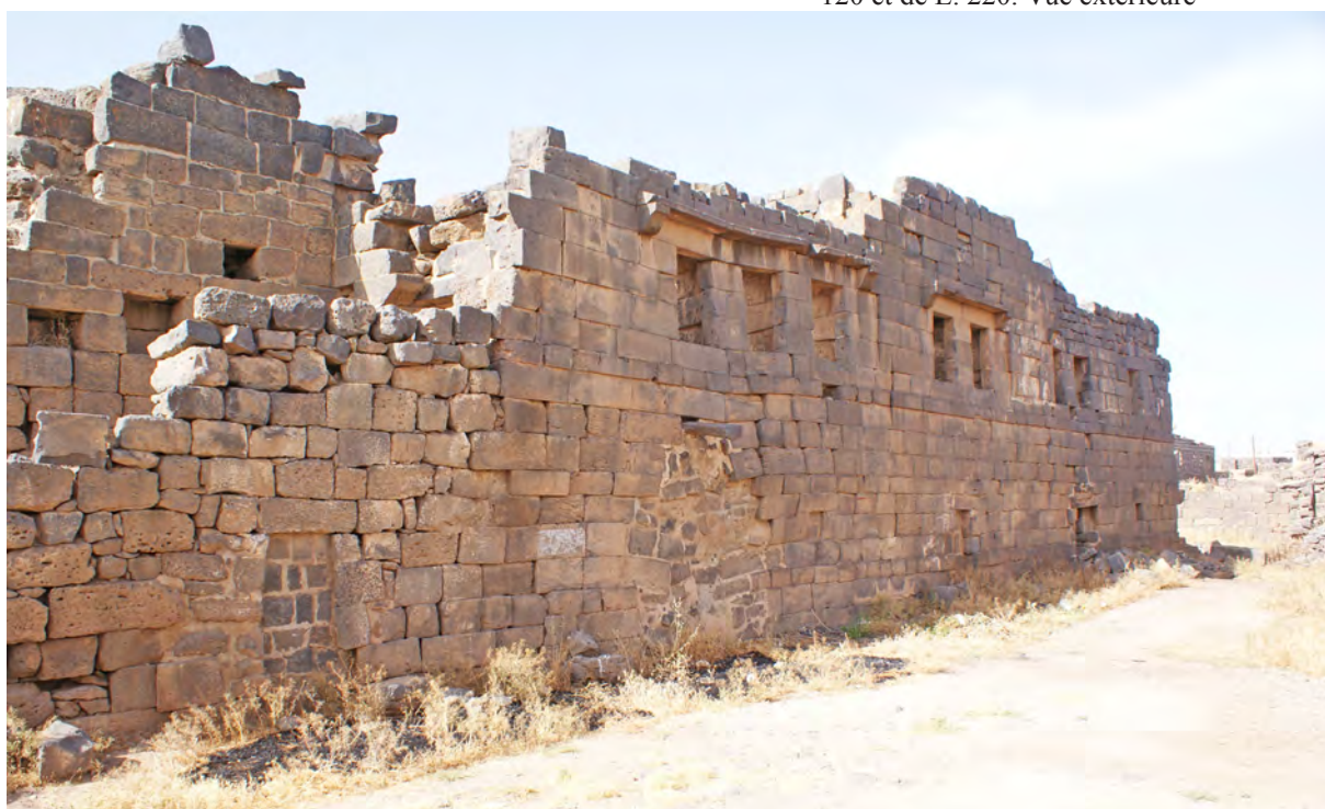
Ph. 43. Bâtiment sud. Façade sud extérieure
