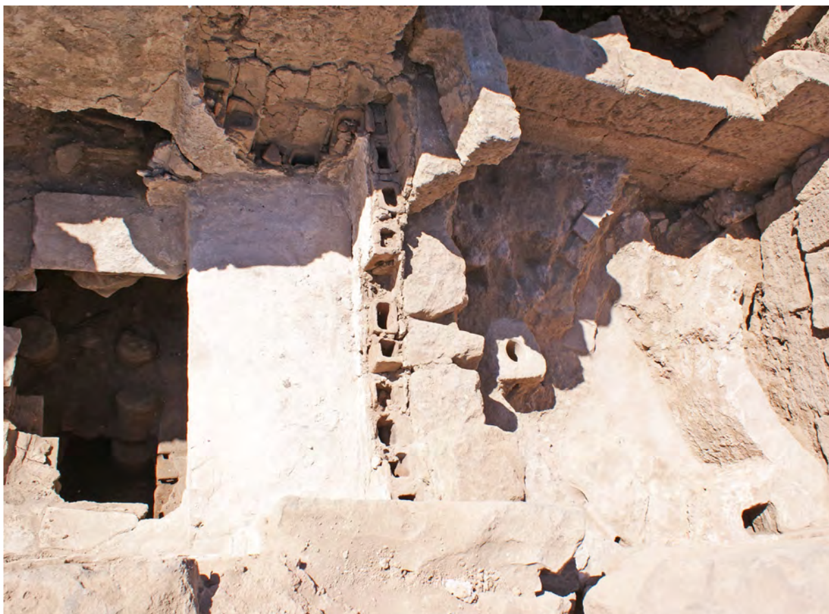
Ph. 118. Les bains. Les tubulures en céramique dans la niche à banquette chauffée de la salle L. 037
