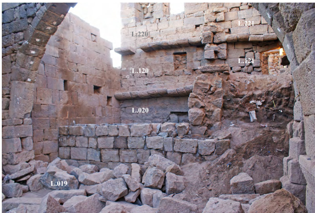
Ph. 30. Bâtiment sud. Au delà de la pièce L. 019, les pièces L. 020, L. 120 et L. 220
