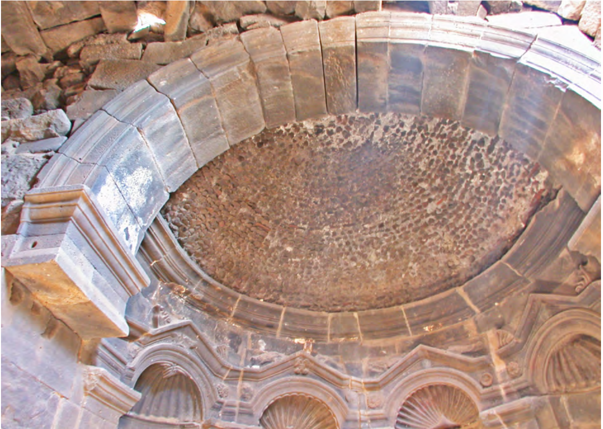
Ph. 201. Bosra. Abside à cul-de-four du monument à narthex 8, situé au nord de la basilique de Bahīrā
