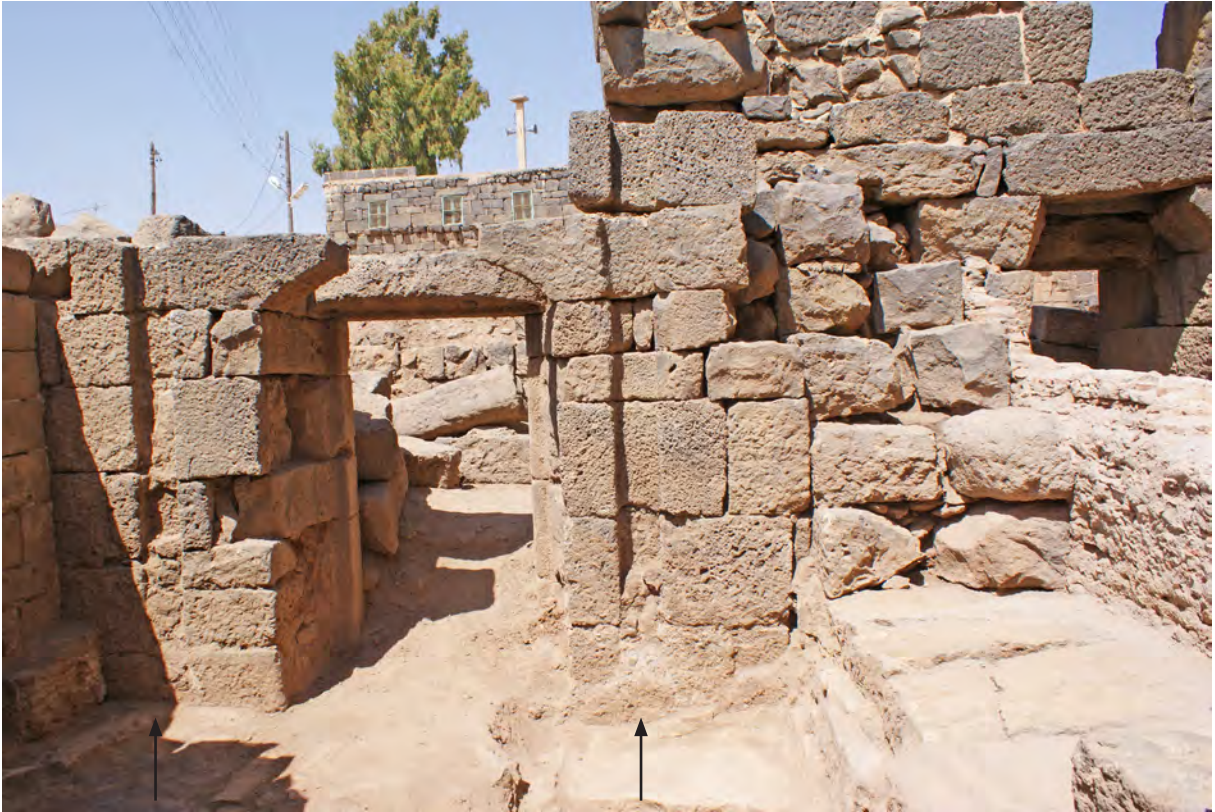
Ph. 133. Les bains. Les cheminées d'évacuation d'air chaud en L. 034, appartenant à l'état original des bains
