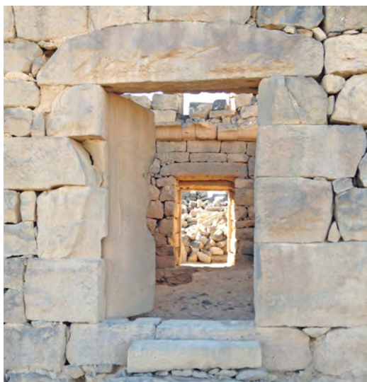
Ph. 195. 'Umm al-Jimāl, Maison XVIII. Vue de l'entrée nord-est, vers l'ouest
