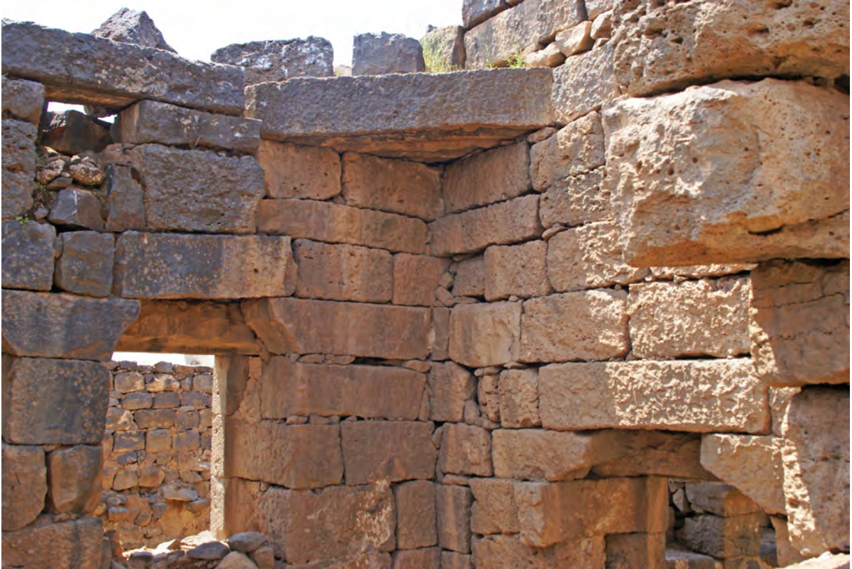
Ph. 211. Le « Palais de Trajan ». Angle ouest de la pièce L. 221. Poutres posées en diagonale
