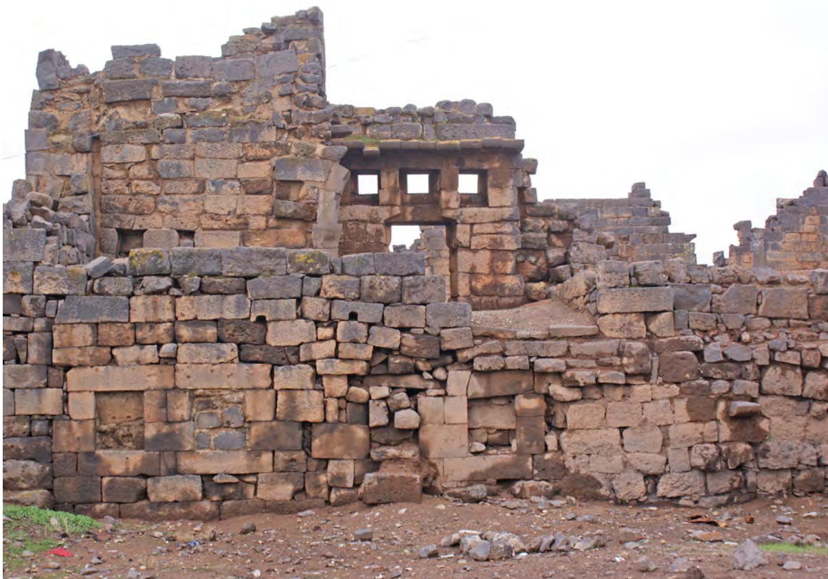
Ph. 82. Bâtiment nord. Façade nord extérieure
