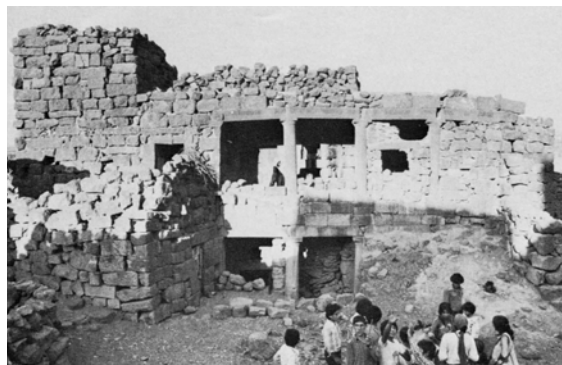
Ph. 218. 'Umm az-Zaytūn. Portique et galerie d'une maison (F. Villeneuve 1985)
