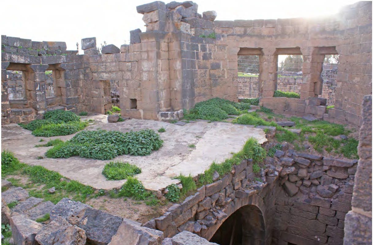
Ph. 49. Bâtiment sud. Vue générale de la salle triconque, vers l'ouest
