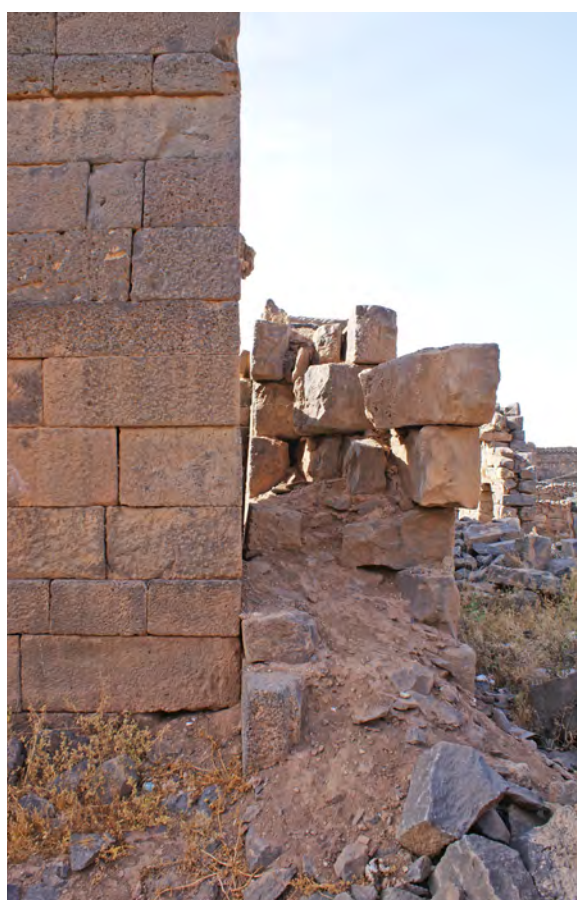
Ph. 61. Le « Palais de Trajan ». La façade sud extérieure adossée au mur à niches
