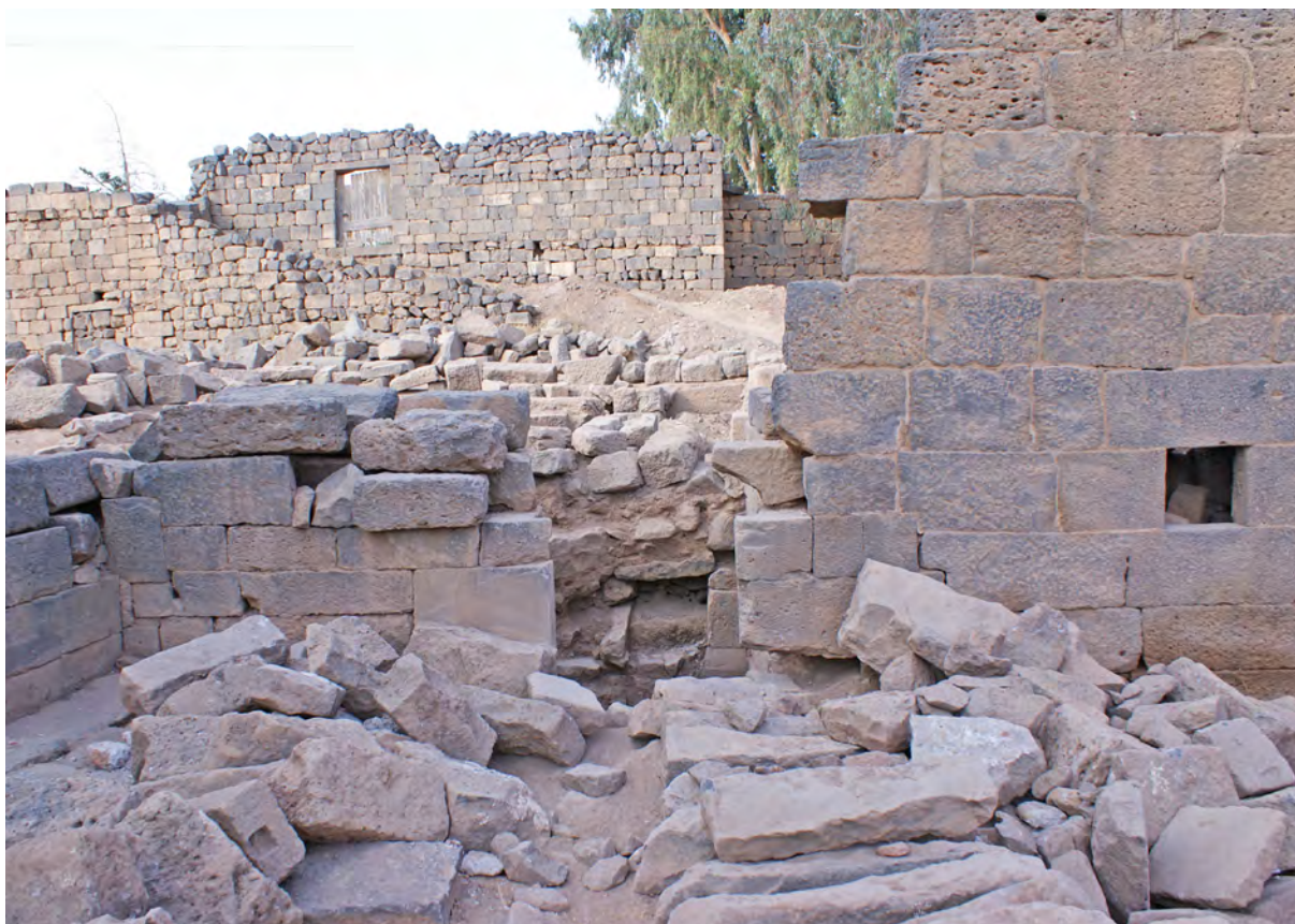
Ph. 88. Les bains. Vue, depuis l'extérieur, de la porte nord-est de L. 030
