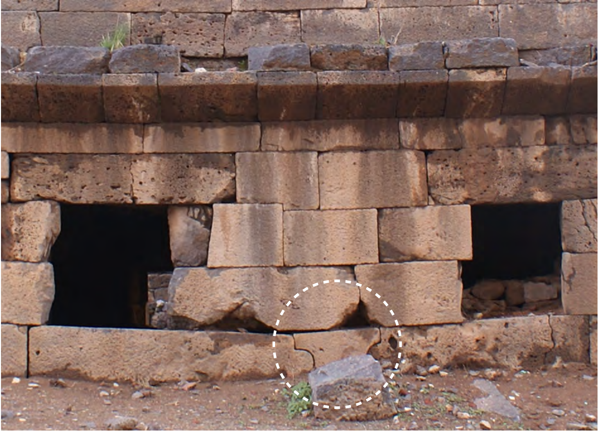
Ph. 11. Bosra, maison 2 « Saint-Serge ». Arc clavé de décharge d'une porte d'entrée
