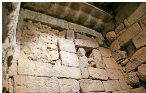
Ph. 67. Le « Palais de Trajan ». Vue intérieure de L. 011. Fenêtres et corbeaux
