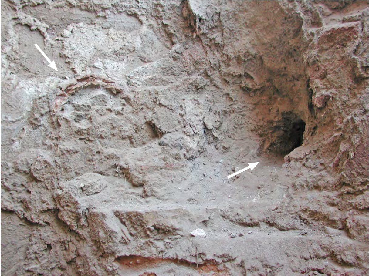
Ph. 127. Les bains. Paroi sud de L. 035, vestige du rebord en céramique d'une hypothétique vasque et canal d'alimentation
