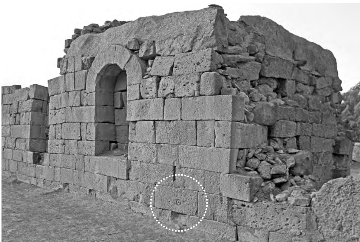
Ph. 74. Le « Palais de Trajan ». Marque de tailleur 3 dans la façade est du bâtiment est (mur à niches)
