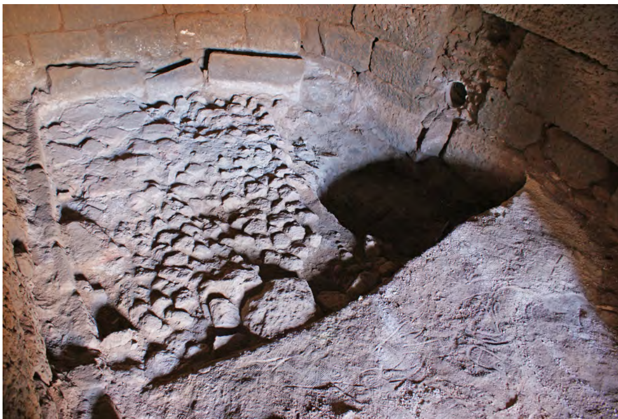
Ph. 189. Le « Palais de Trajan ». Radier de scories couvert de fragments de brique dans la salle L. 027.
