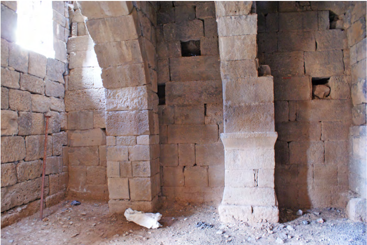
Ph. 33. Bâtiment sud. Piédroit oriental de l'arc de la salle L. 019
