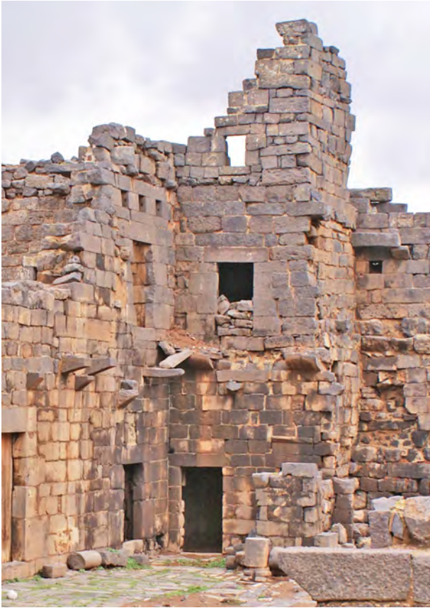
Ph. 78. Bâtiment nord. Angle nord-est de la cour
