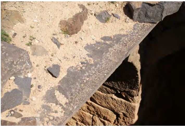
Ph. 206. 'Umm al-Jimāl, le « Prétoire ». Lit d'attente de l'encorbellement pour la couverture de la salle cruciforme
