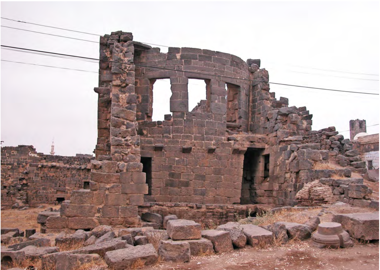
Ph. 56. Bâtiment sud. Façade ouest
