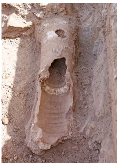
Ph. 155. Le « Palais de Trajan ». Tuyaux longeant la façade sud sur cour
