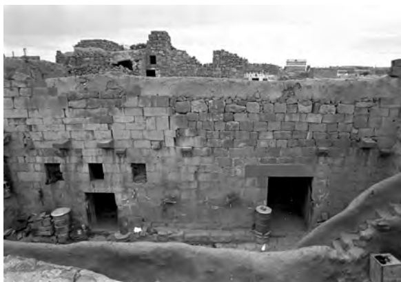
Façade du bâtiment nord sur cour
