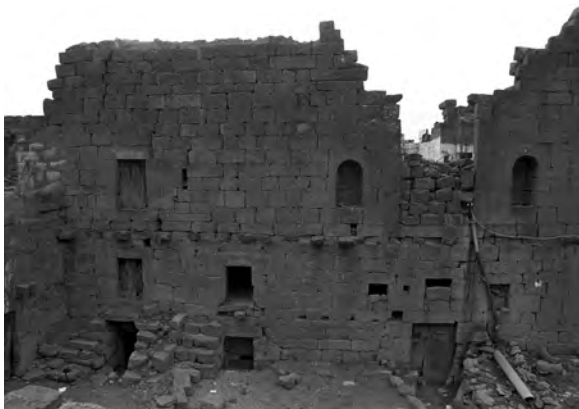
Façade du bâtiment sud sur cour
