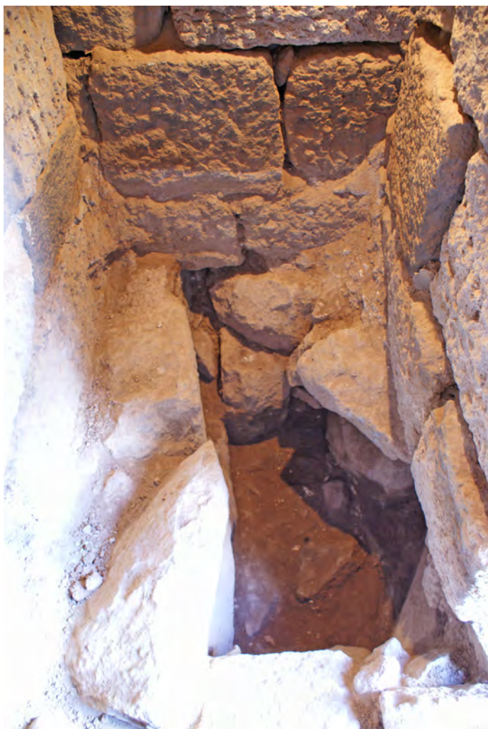
Ph. 142. Le « Palais de Trajan ». Sous la façade sud sur cour, mur plus ancien dans L. 027, vers l'ouest
