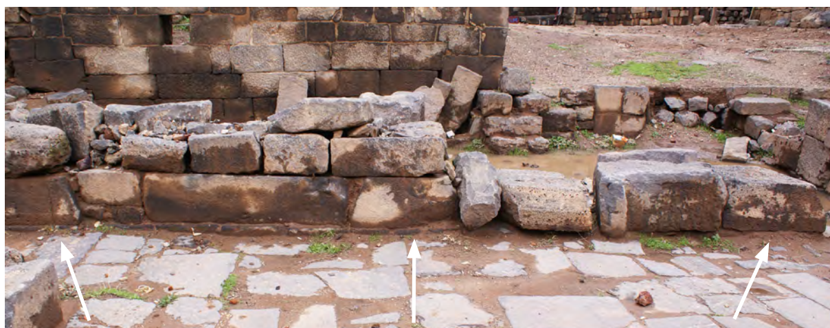
Ph. 22. Le « Palais de Trajan », dés des piliers du portique ouest
