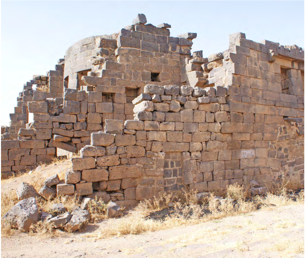
Ph. 44. Bâtiment sud. Angle sud-ouest extérieur
