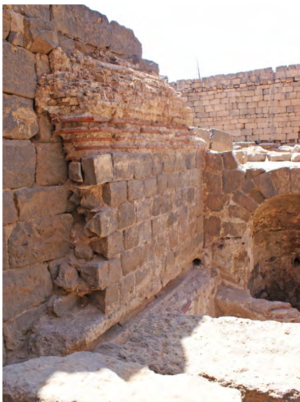
Ph. 105. Les bains. Salle L. 036, moellons et briques de la voûte, détail
