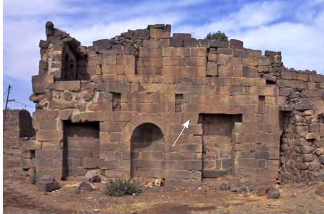
Ph. 69. Le « Palais de Trajan ». Vue de l'extrémité sud du mur à niches en 1997 (la flèche indique l'inscription latine)
