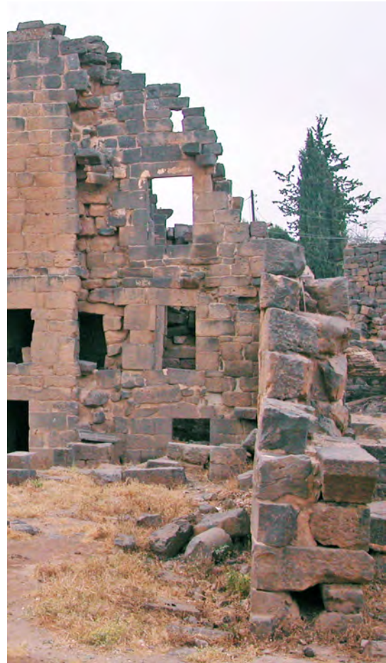
Ph. 28. Bâtiment sud. Façade intérieure de l'escalier L.007
