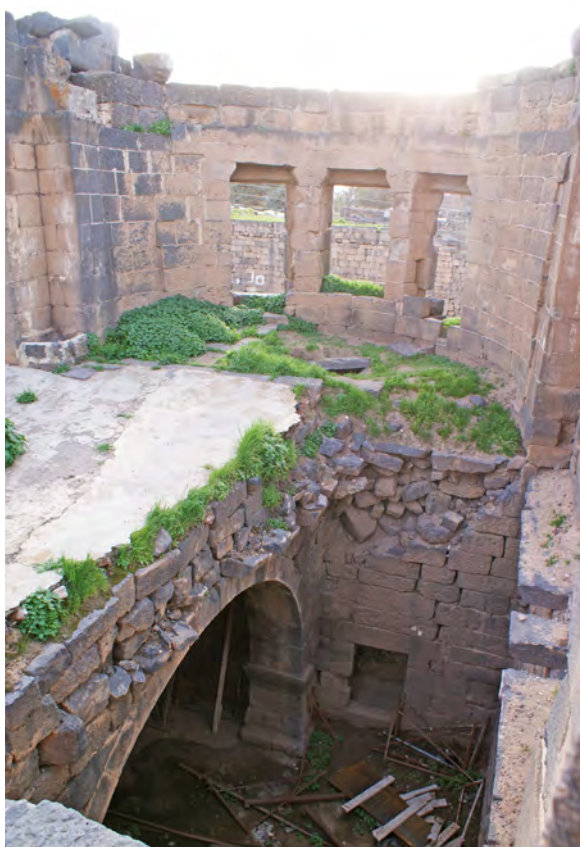
Ph. 38. Bâtiment sud. Les corbeaux portés par l'arc dans la salle L. 025
