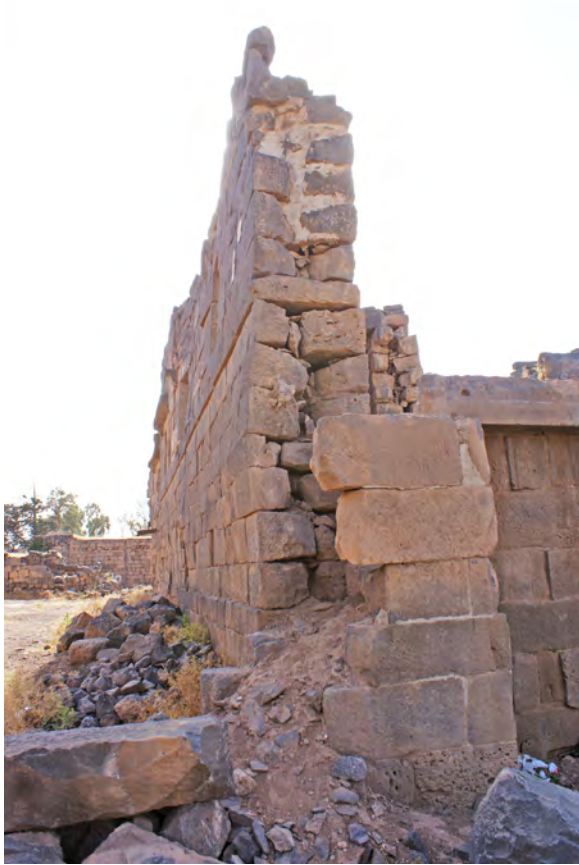
Ph. 62. Le « Palais de Trajan ». Extrémité est de la façade sud extérieure, vers l'ouest
