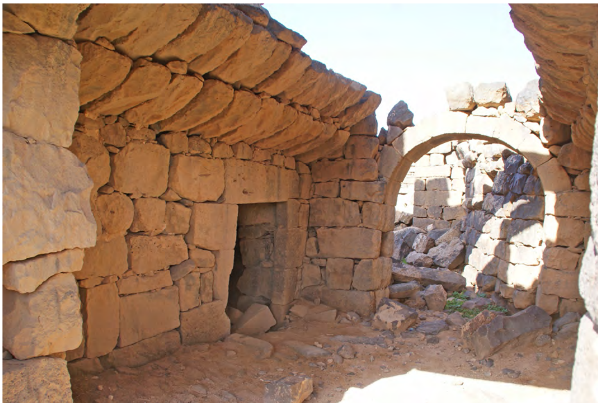
Ph. 192. 'Umm al-Jimāl, maison XVI. vue intérieure du porche, vers le nord
