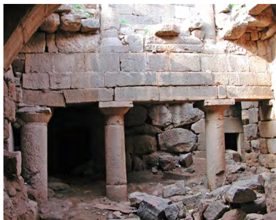
Ph. 219 Shaqqā, Qaysariyya . Portique et galerie
