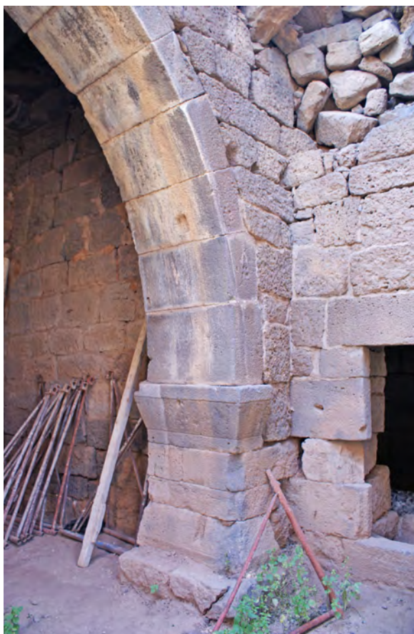
Ph. 36. Bâtiment sud. Porte et piédroit à l'ouest de L. 025
