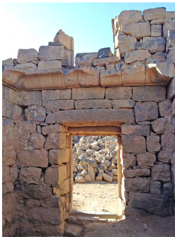
Ph. 196. 'Umm al-Jimāl, Maison XVIII. corniche dans l'entrée nord-est, vers l'ouest
