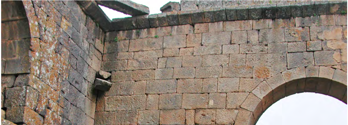
Ph. 205. Shaqqā, Qaysariyya . Au sommet de la grande salle carrée, poutre posée en diagonale
