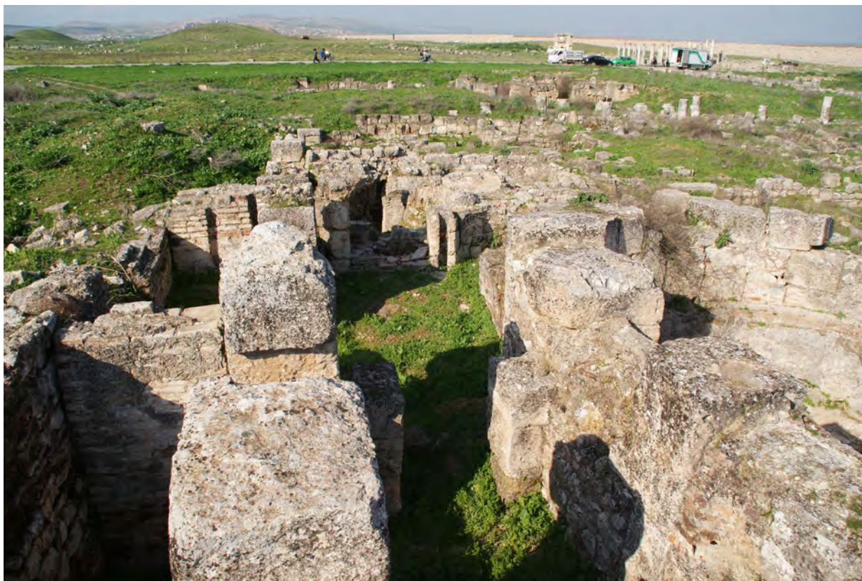
Ph. 224. Apamée, « Maison au triclinos ». Les salles chauffées (d et e'), vers le nord
