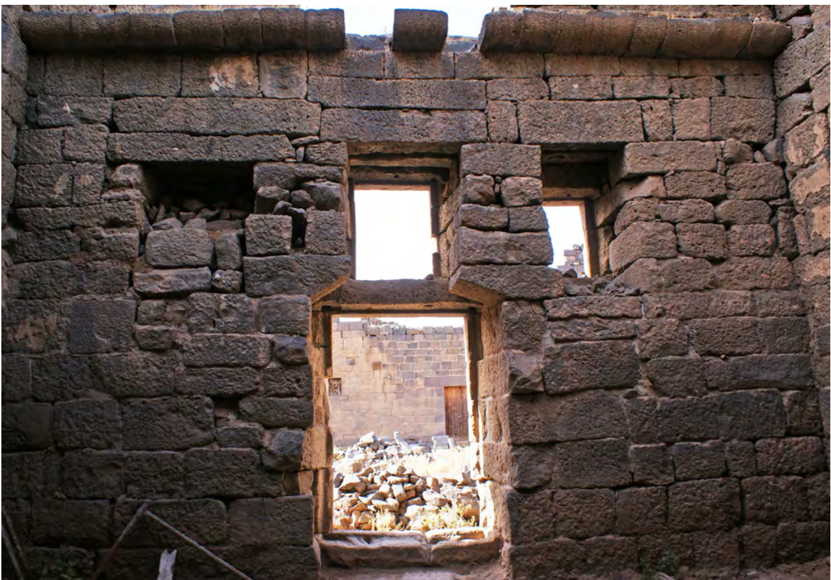
Ph. 35. Bâtiment sud. Vue intérieure de la porte d'entrée de L. 025
