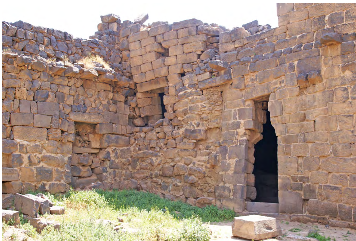
Ph. 31. Bâtiment sud. Angle nord-est de la salle L. 019, depuis la cour
