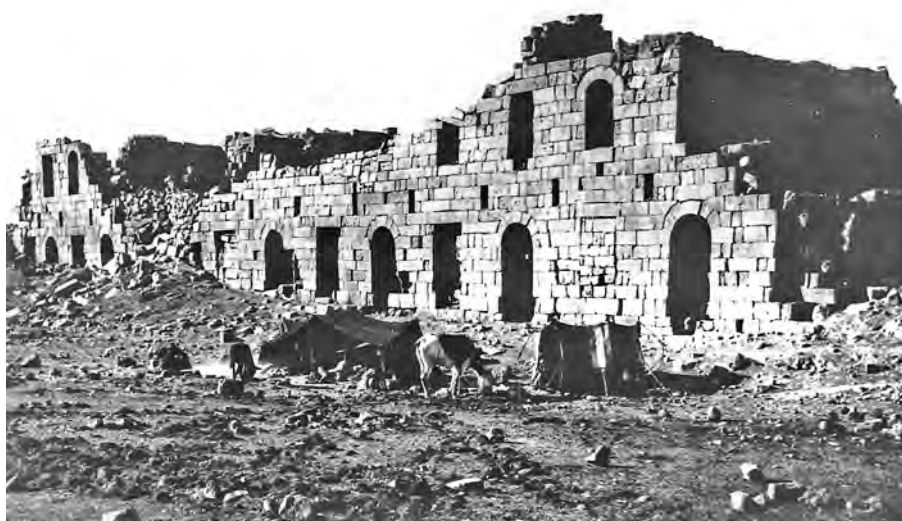
Ph. 68. Le « Palais de Trajan ». Bâtiment est, le mur à niches en 1930 (Fonds d'archives Maurice Dunand)
