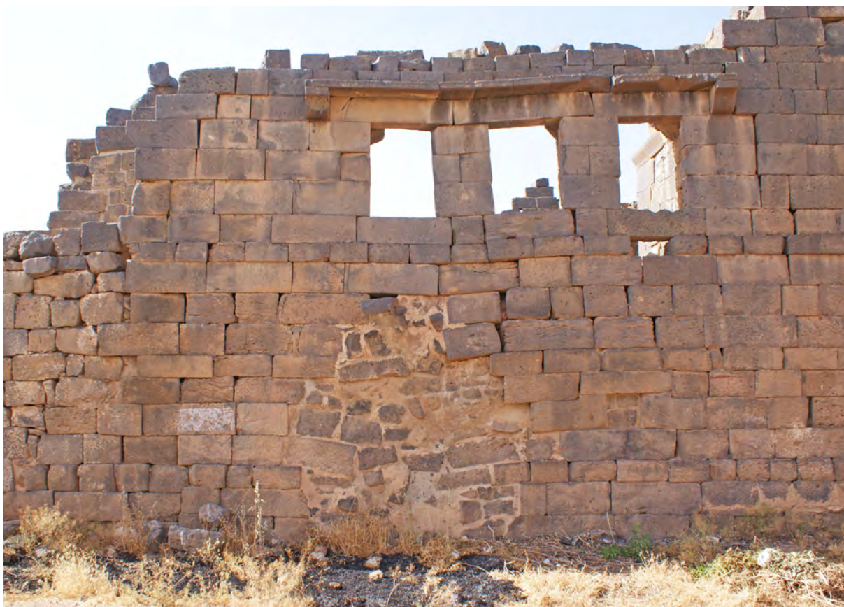
Ph. 59. Le « Palais de Trajan ». Grandes fenêtres de l'étage de la façade sud extérieure
