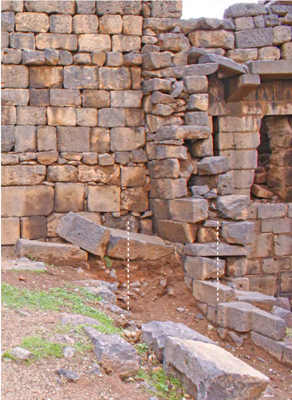
Ph. 83. Bâtiment ouest. Porte d'accès à la cour depuis l'hypothétique entrée du « Palais de Trajan »
