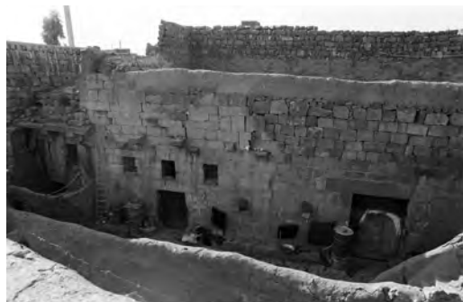
Façade du bâtiment nord sur cour
