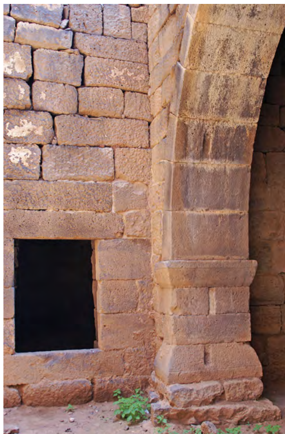
Ph. 37. Bâtiment sud. Porte et piédroit à l'est de L. 025
