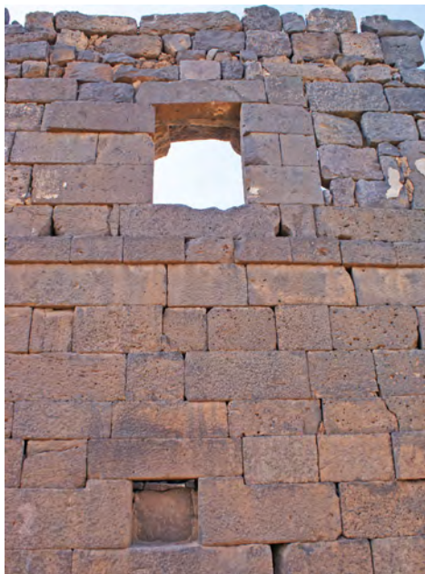
Ph. 42. Bâtiment sud. Fenêtres de L. 120 et de L. 220. Vue extérieure
