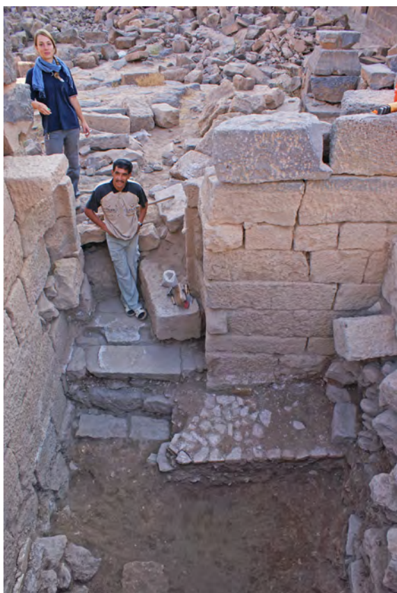
Ph. 89. Les bains. Vue, depuis l'intérieur, de la porte nord-est de L. 030
