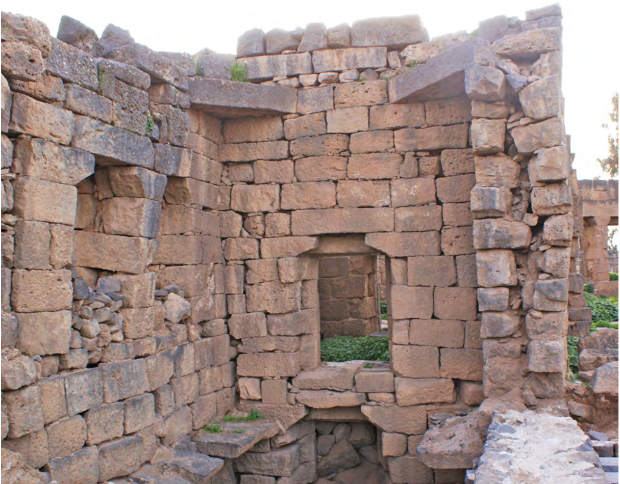
Ph. 50. Bâtiment sud. Angles sud-ouest et nord-ouest de L. 221. Poutres posées en diagonale
