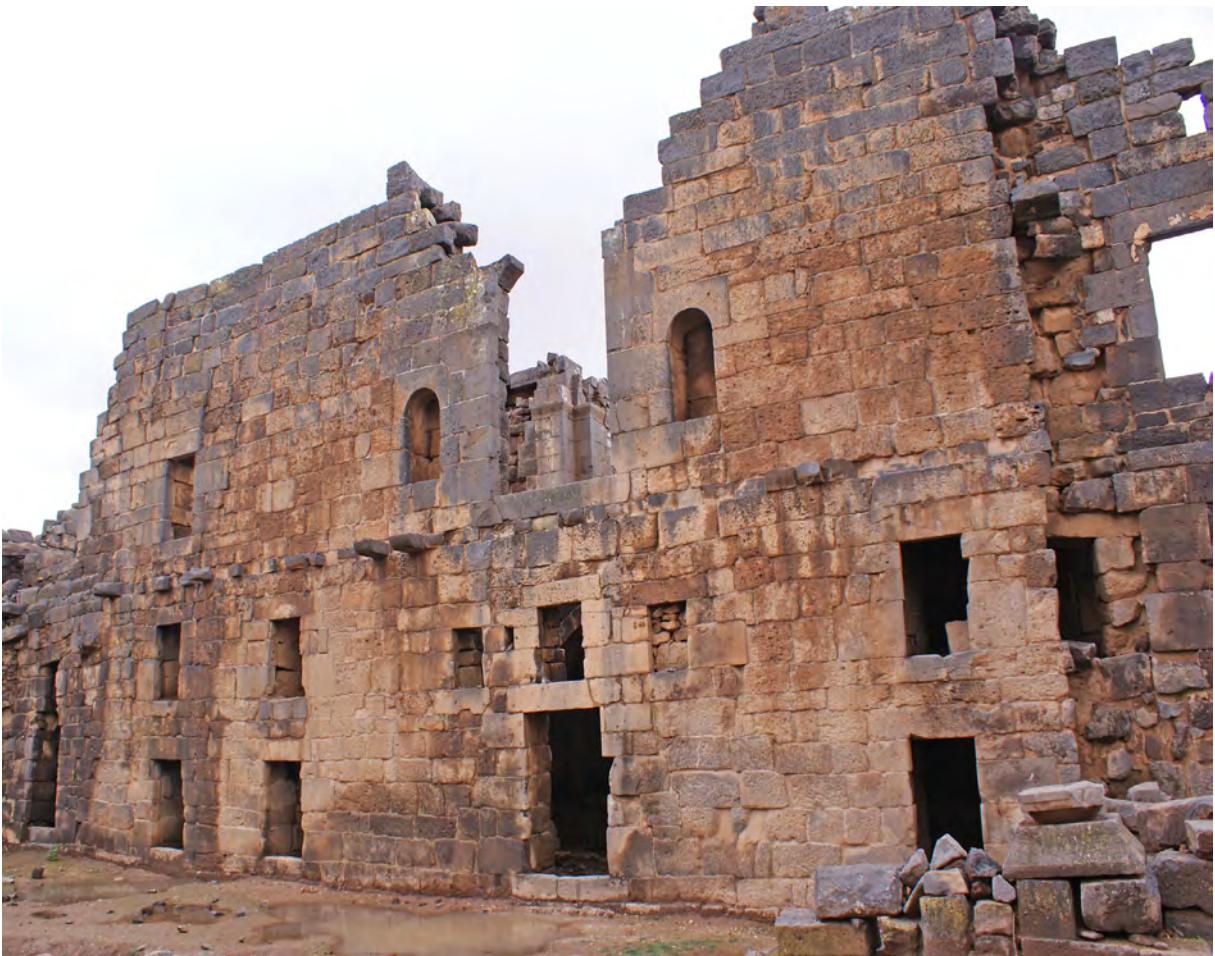
Ph. 26. Bâtiment sud. Façade sud sur cour
