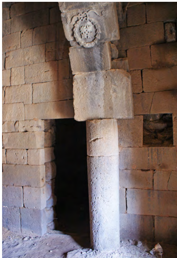
Ph. 76. Bâtiment nord. Salle L. 010. Arc tardif remployant un claveau orné d'une couronne
