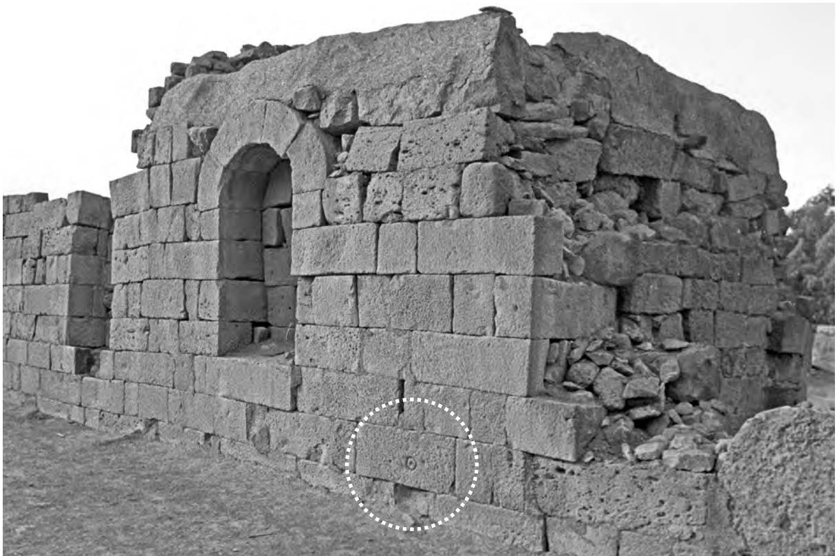
Ph. 74. Le « Palais de Trajan ». Marque de tailleur 3 dans la façade est du bâtiment est (mur à niches)
