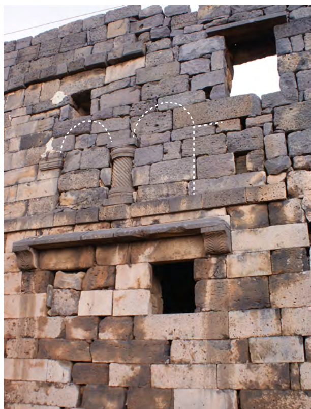
Ph. 14. Bosra, baie et colonne torsadée à l'étage de la maison 3
