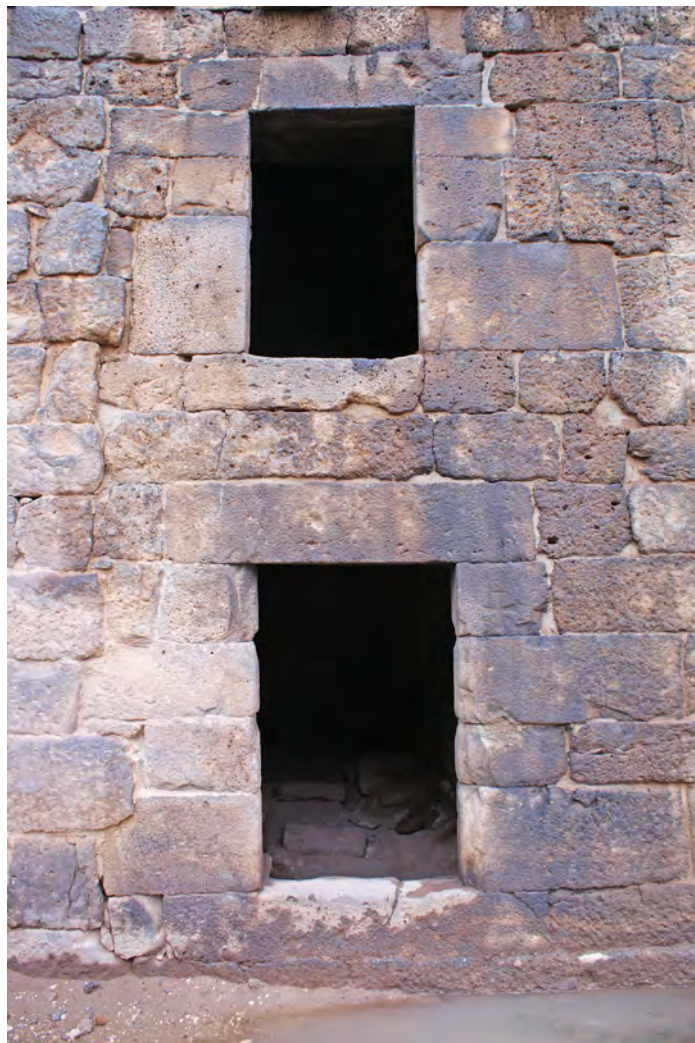
Ph. 58. Le « Palais de Trajan ». Ravalement des blocs d'encadrement des portes de la façade sur cour du bâtiment sud
