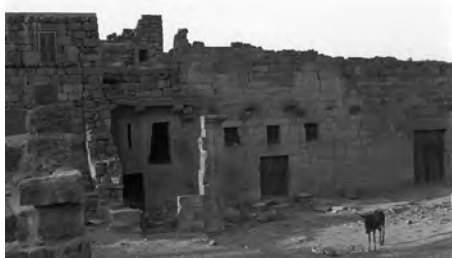
Façade du bâtiment nord sur cour
