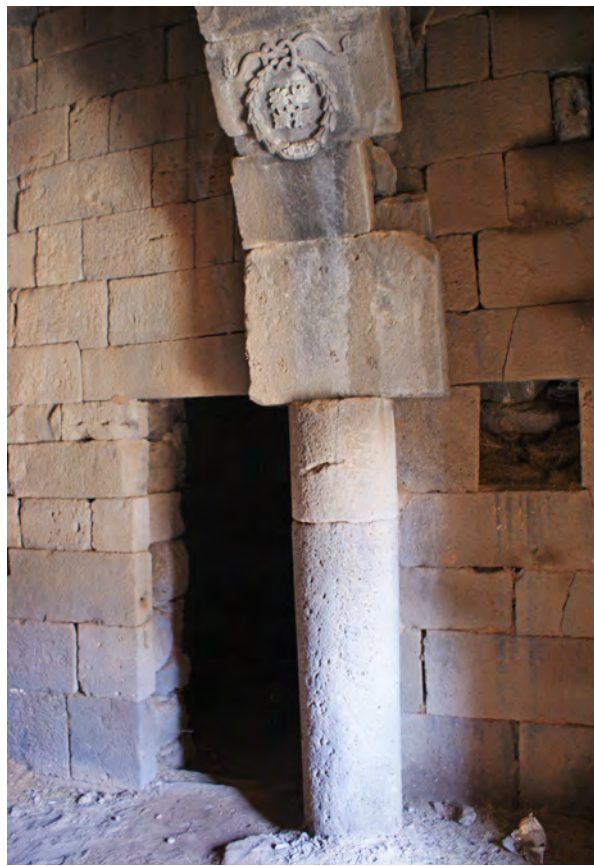
Ph. 76. Bâtiment nord. Salle L. 010. Arc tardif remployant un claveau orné d'une couronne
