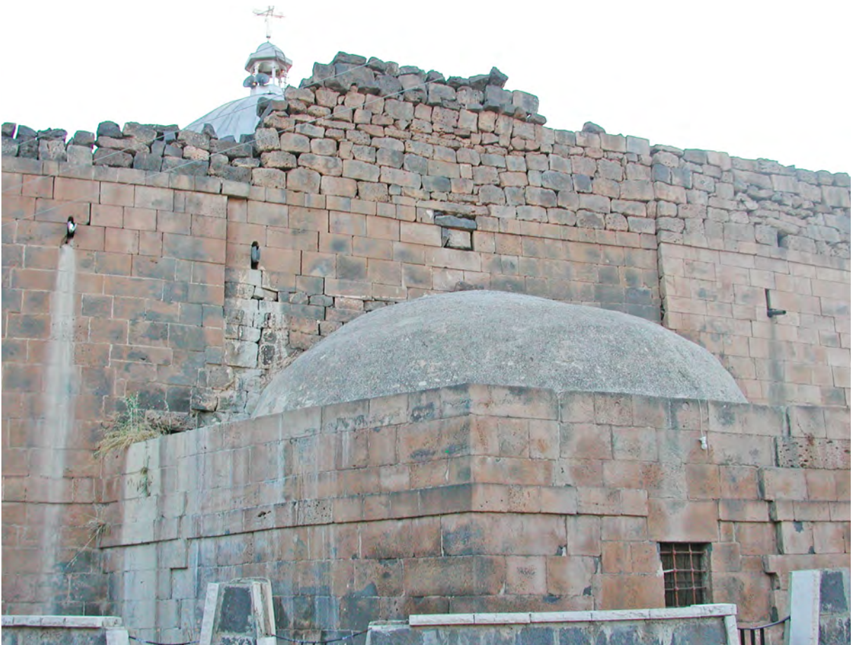
Ph. 202. Ezra'. Cul-de-four maçonné couvrant l'abside de l'église Saint-Georges
