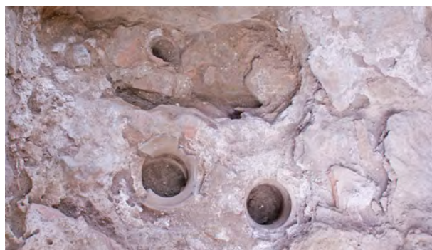
Ph. 124. Les bains. Dans l'épaisseur de la porte de L. 035, trois tuyaux verticaux
