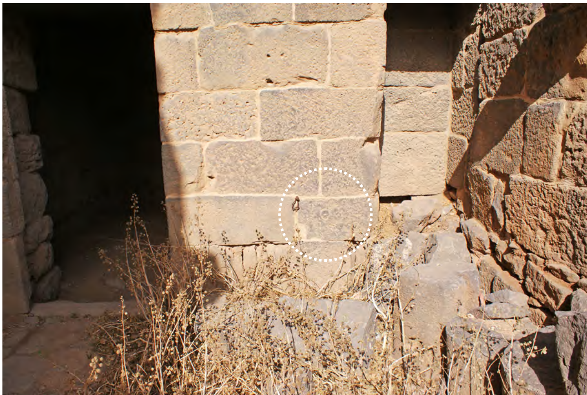
Ph. 73. Le « Palais de Trajan ». Marque de tailleur 2 dans la façade ouest sur portique du bâtiment est
