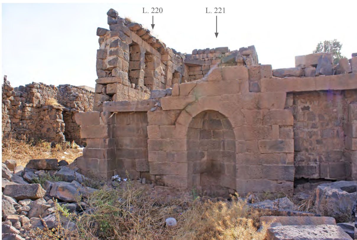
Ph. 46. Bâtiment sud. Vue de l'angle sud-est, depuis l'est, en 2009. Au premier plan, le mur à niches
