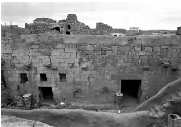
Façade du bâtiment nord sur cour
