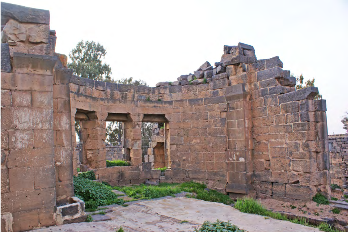
Ph. 51. Salle triconque. Pilastres sud-ouest de l'abside L.227
