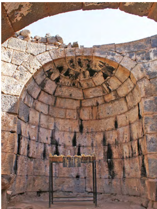
Ph. 199. Qanawat, le « Séraïl ». Cul- de-four appareillé dans le triconque
