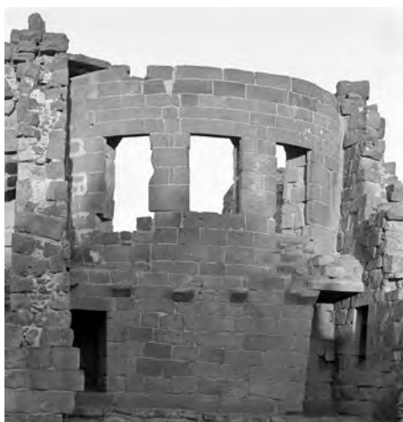
Abside ouest du triconque depuis l'extérieur
