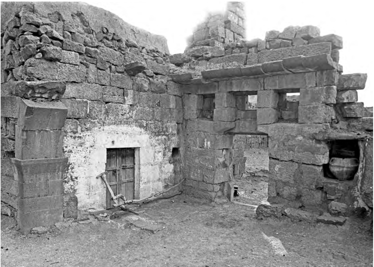
Ph. 79. Bâtiment nord. Salle L. 210, vers le sud-est (MAFSS 1975)
