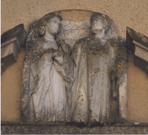
Fig. 83 : Stèle de couple en remploi dans la façade du château de Savigny-les-Beaune (Éd-740) (cliché Anne-Laure Edme)
