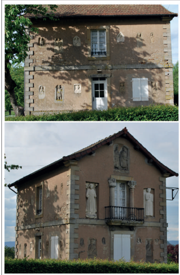
Fig. 85 : Autun, Maison des Caves Joyaux, façades sud et est (clichés Anne-Laure Edme)
