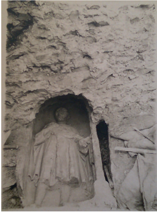
Fig. 69 : Photographie prise en 1925, lors de travaux au niveau du castrum dijonnais, rue Vauban (tiré du fonds de la CACO, 69 J 73)
