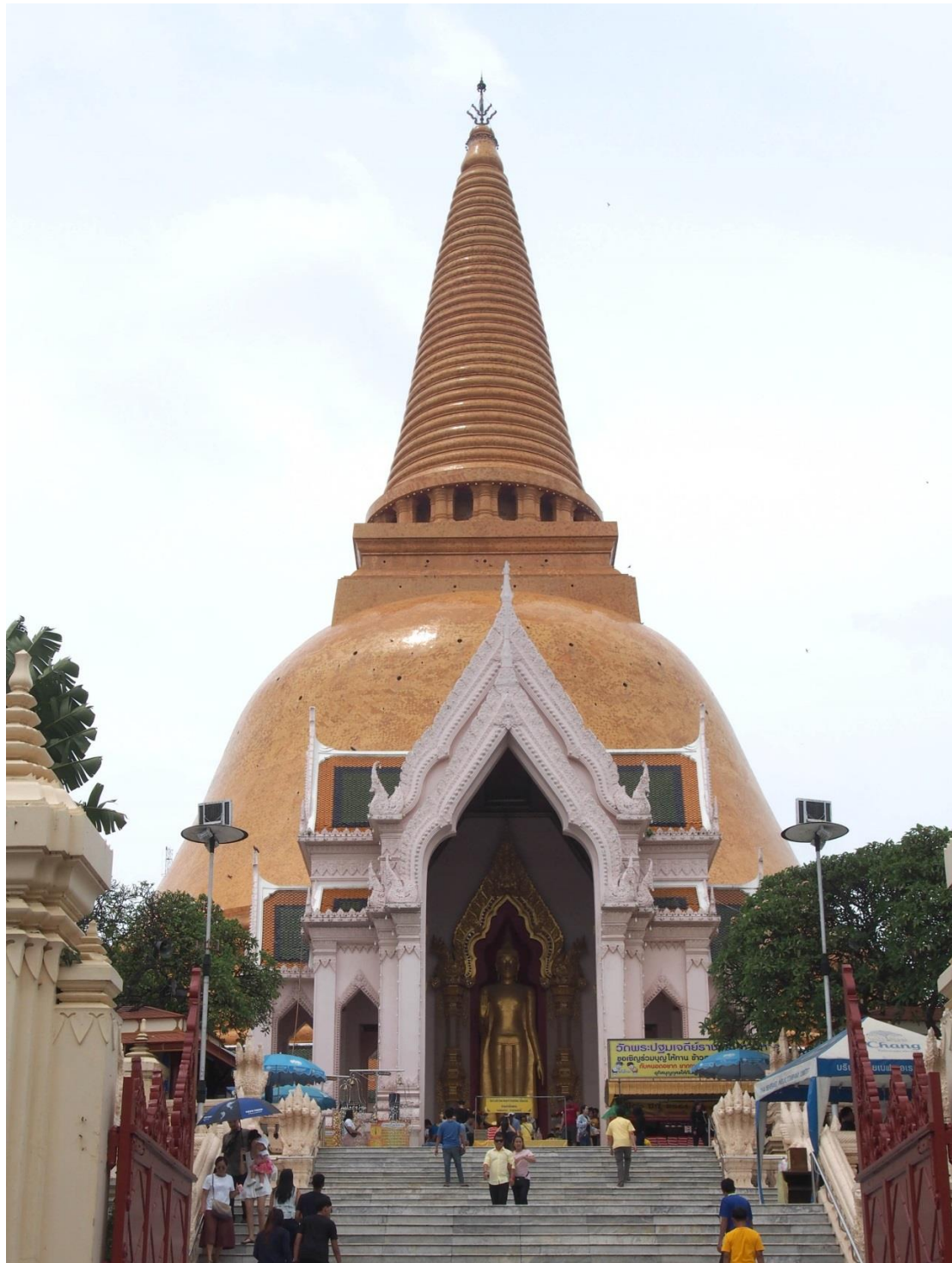
Figure 7. Le stupa Phra Pathom Chedi après la restauration dirigée par le roi Mongkut dans les années 1860 L'édifice est constitué d'un corps en forme de cloche et couronné d'une flèche terminale de forme conique selon le modèle des stupa singhalais.
