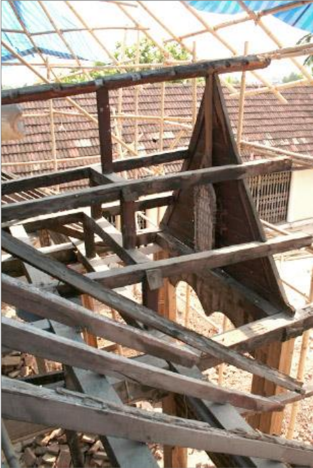
Figure 37. Le démontage de la structure de la toiture pendant les travaux de restauration
