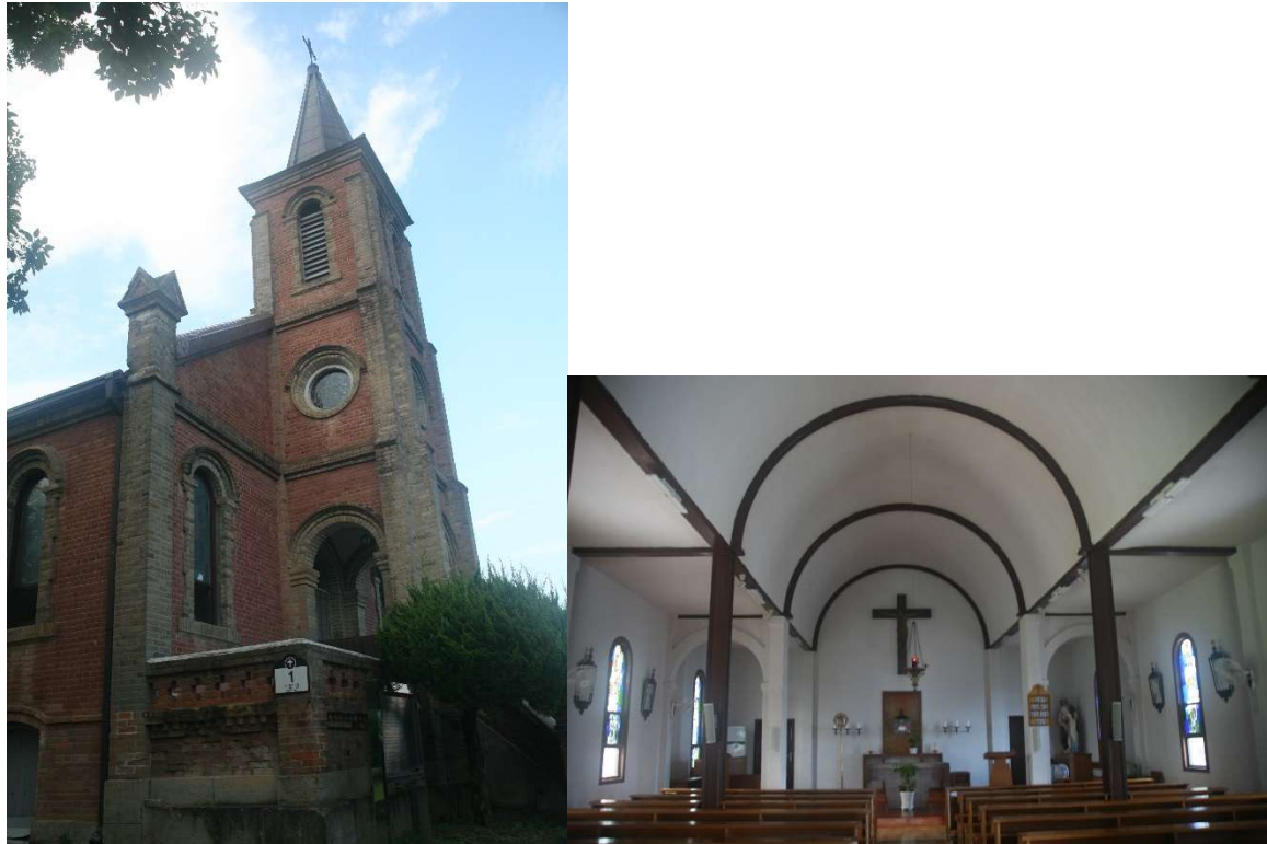
Figure 44 Eglise de Gasil à Chilgok
