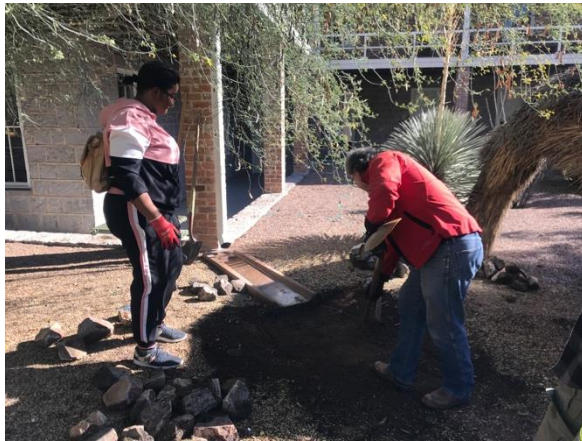
Figure 45 : Chantier collectif sur le campus de l'Université d'Arizona pour rénover les bassins de collecte des eaux de pluie (10/12/2019)
