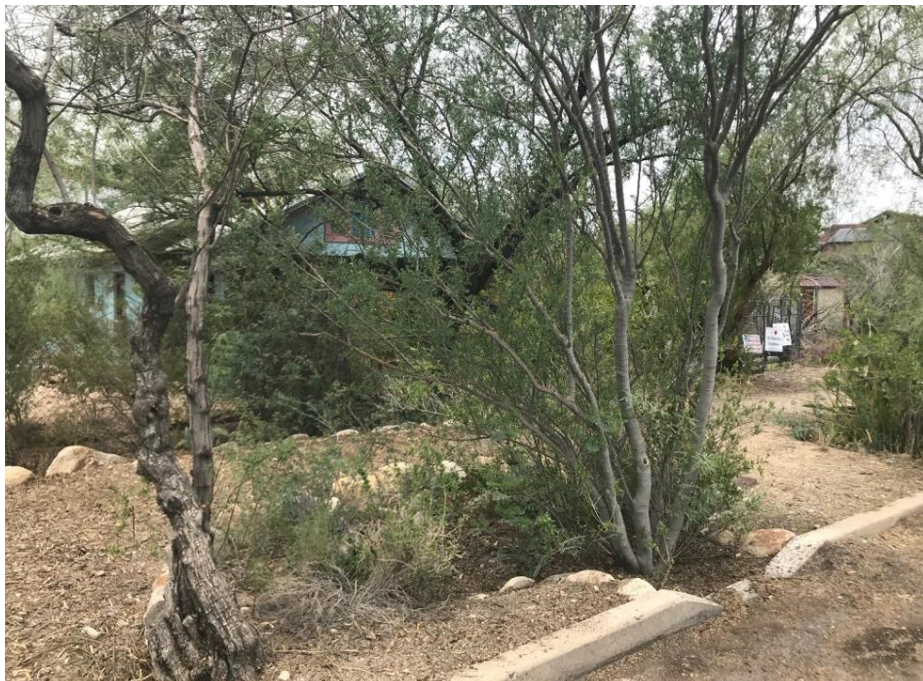
Figure 70 : Exemple de collecte passive des eaux pluviales dans le quartier de Dunbar Spring à Tucson : le trottoir est entaillé afin de diriger le ruissellement vers un bassin où est installée la végétation (août 2018)
