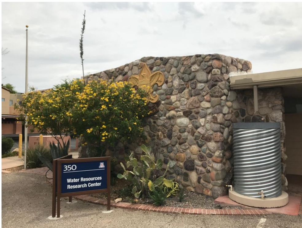
Figure 81 : Système de collecte des eaux de pluie du Water Resources Research Center sur le campus de l’Université d’Arizona (juin 2018)
