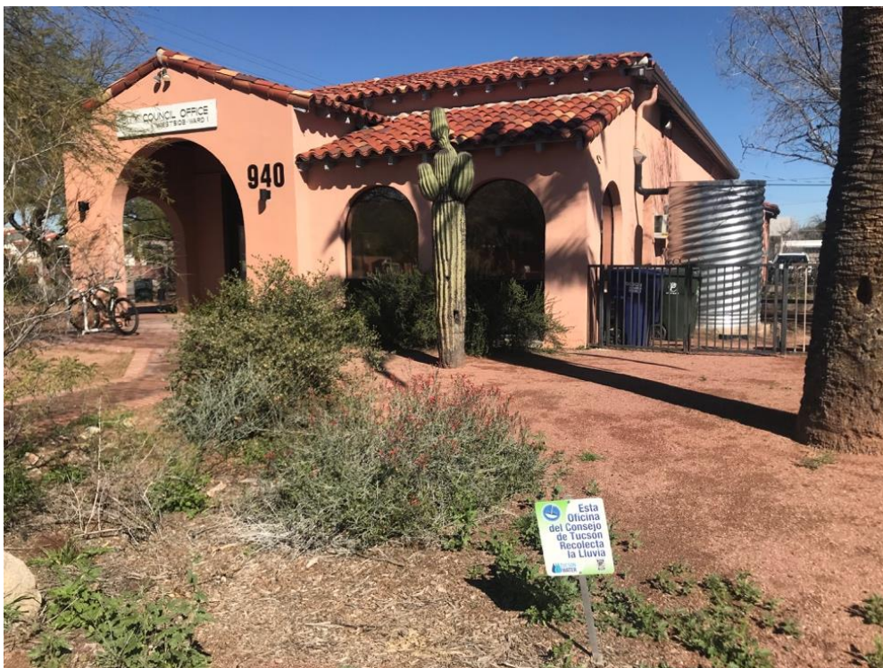
Figure 69 : Les locaux du Ward 1 à Tucson équipés d'un système actif de collecte des eaux de pluie (mars 2019)
