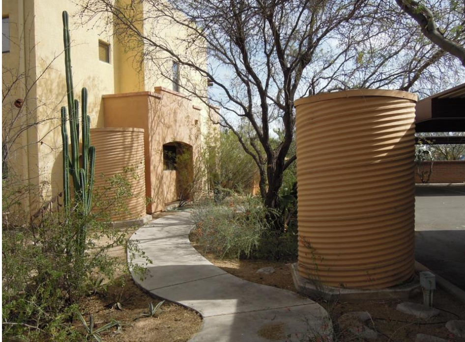
Figure 71 : Exemple de collecte active des eaux de pluie dans la résidence Stone Co-Housing Community à Tucson (avril 2018)
