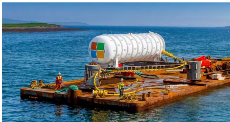
Figure 14 : Data center sous-marin de Microsoft, déployé en Écosse en 2018 (Source : lebigdata.fr)
