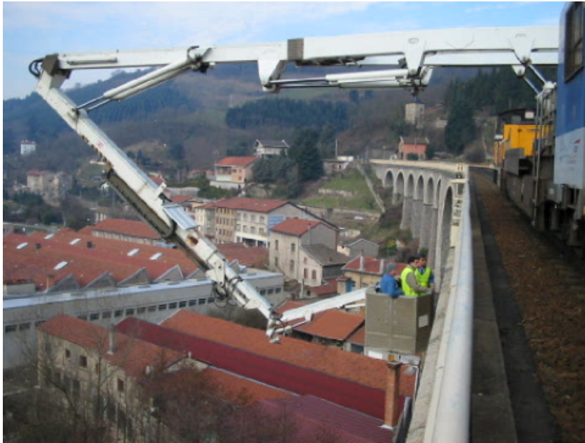
FIGURE 1.2 – Exemple d’inspection des ouvrages d’art (source internet)
