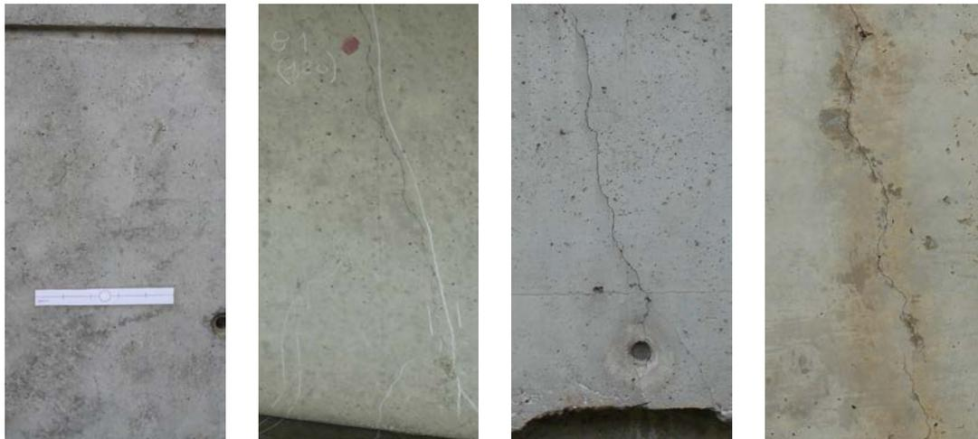
FIGURE 2.1 – Exemples de fissures de différentes tailles sur divers murs en béton.
