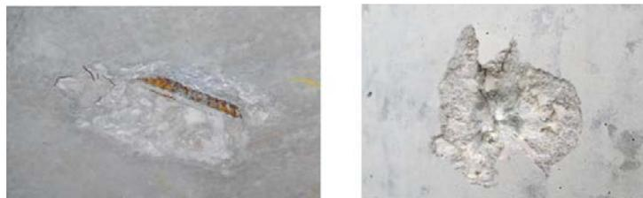
FIGURE 5.1 – (Gauche) Défaut avec fer apparent (Droite) Défaut sans fer apparent.
