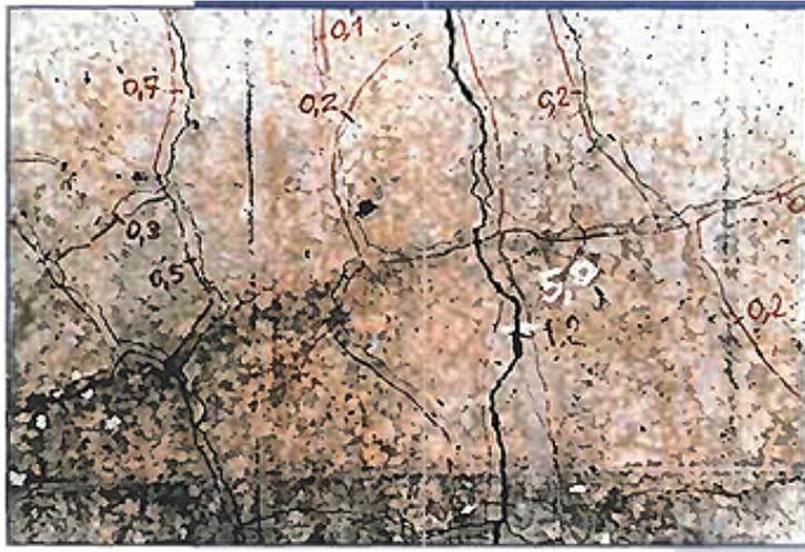
FIGURE 2.5 – Photographie d'une surface de béton présentant une fissuration caractéristique due à l'alcali-réaction [Baron, 1996].
