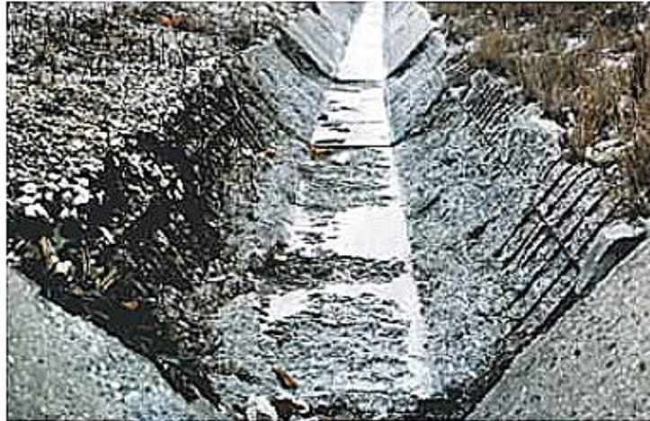
FIGURE 2.3 – Ecaillage et gel d’un caniveau [Baroghel-Bouny, 2003].
