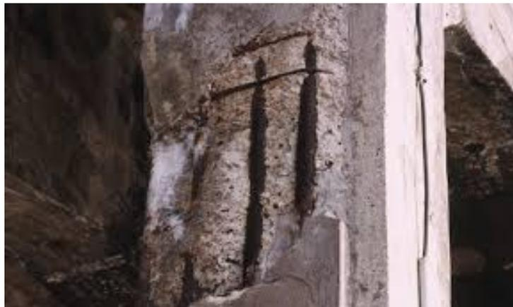
FIGURE 2.8 – Éclatement du béton d'enrobage et corrosion des armatures [IFSTTAR and CEREMA, 2015].
