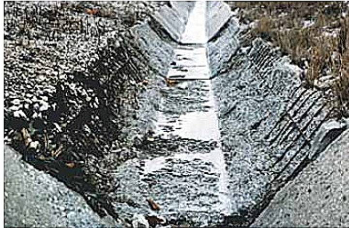
FIGURE 2.3 – Ecaillage et gel d’un caniveau [Baroghel-Bouny, 2003].
