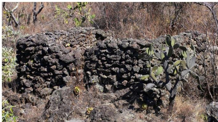
**Figure 48 : Exemple d'un édifice cellulaire aux murs faits de pierres anguleuses. Les pierres sont relativement calibrées, mais très peu travaillées. Peu de mortier est resté en place.**
