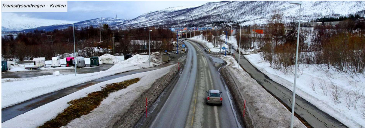
Photo 11.9 : Exemple de partage de la voirie dans la banlieue de Tromsø
