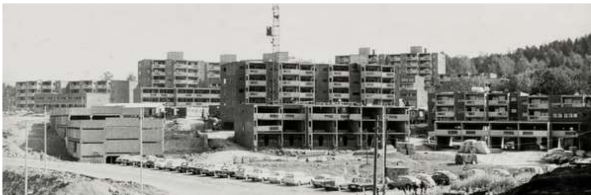
Photo 9.6 : Construction de logements collectifs à Furuset en 1978
