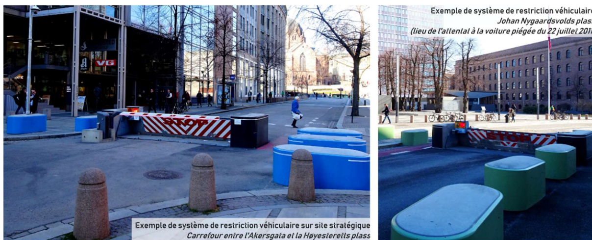
Photos 9.15 : Systèmes de restriction automobile à des fins sécuritaires
