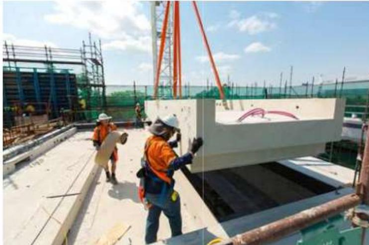
*Figure I-3 Utilisation du Pyrament® (issu de geopolymers.org)*
