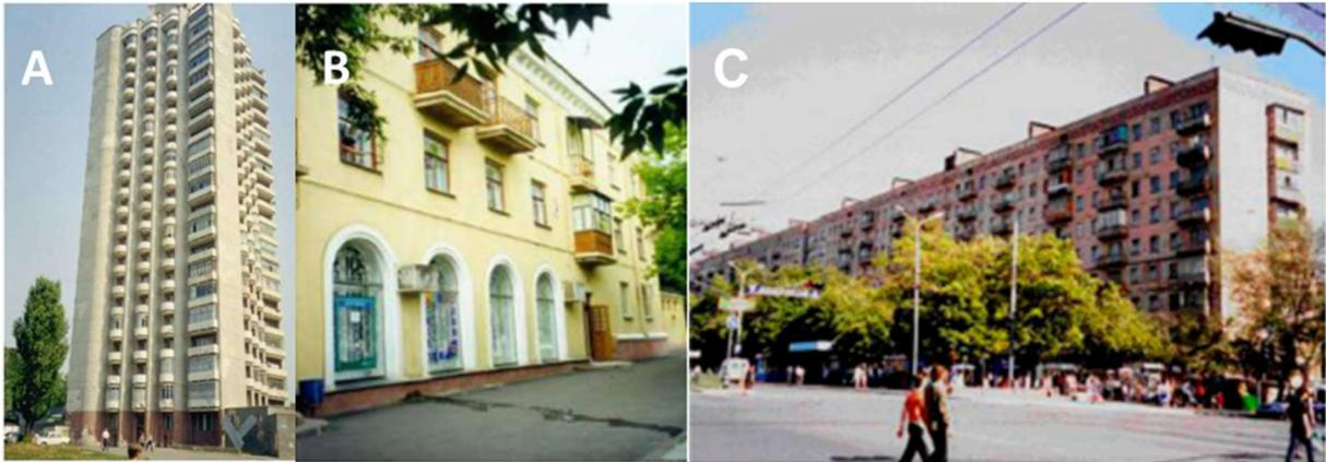
Figure I-1 Bâtiment construit en matériaux à activation alcaline (A- Lipetsk, Russie 1994 B- et C- Mariupol, Ukraine 1960 ; photos issues de Favier, 2014 et Palomo et al., 2014)
