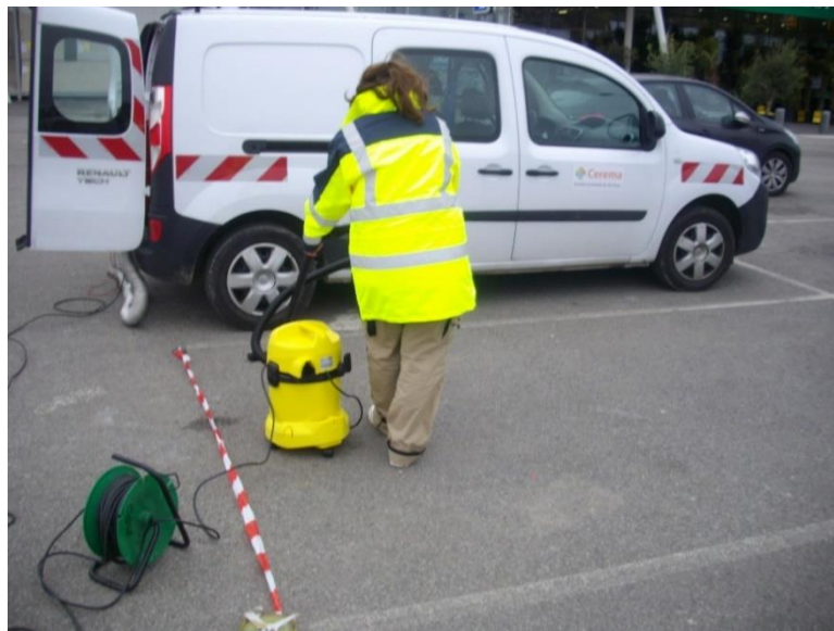
Figure VI.137 : Aspiration à sec de poussières polluées sur un parking en enrobé imperméable (Castorama, Coignières, 23/03/2018)
