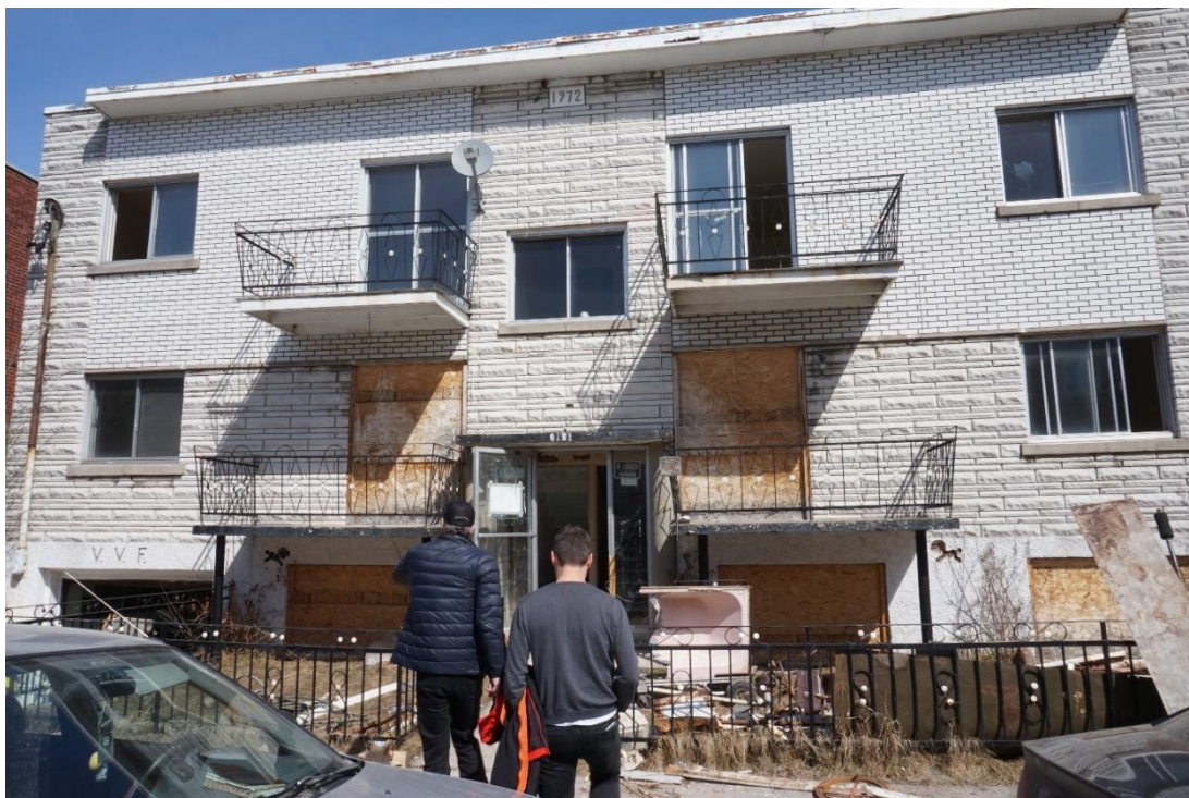
Figure 98 - Le 8151 Avenue Stuart, l'immeuble évacué par la Ville de Montréal en 2011 est encore vide début 2017
