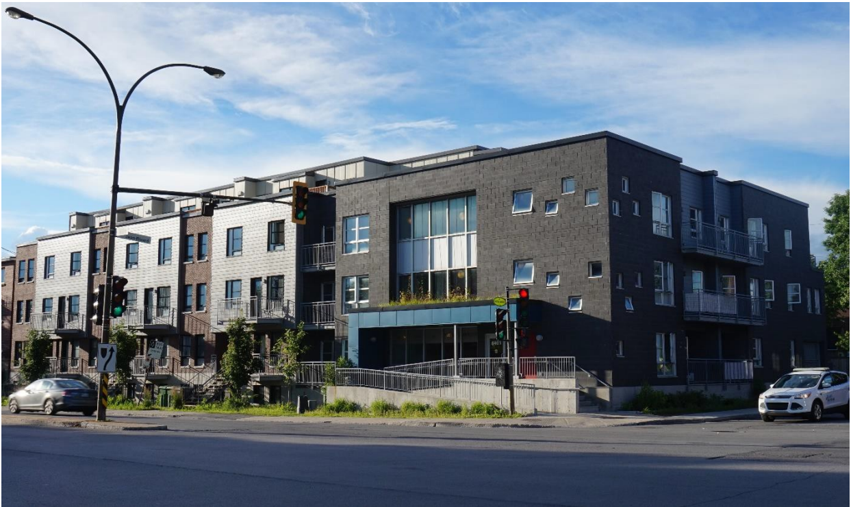
Figure 102 - La Fraternité Micheloise, une mobilisation citoyenne en collaboration avec la Joujouthèque pour construire des grands logements pour familles
