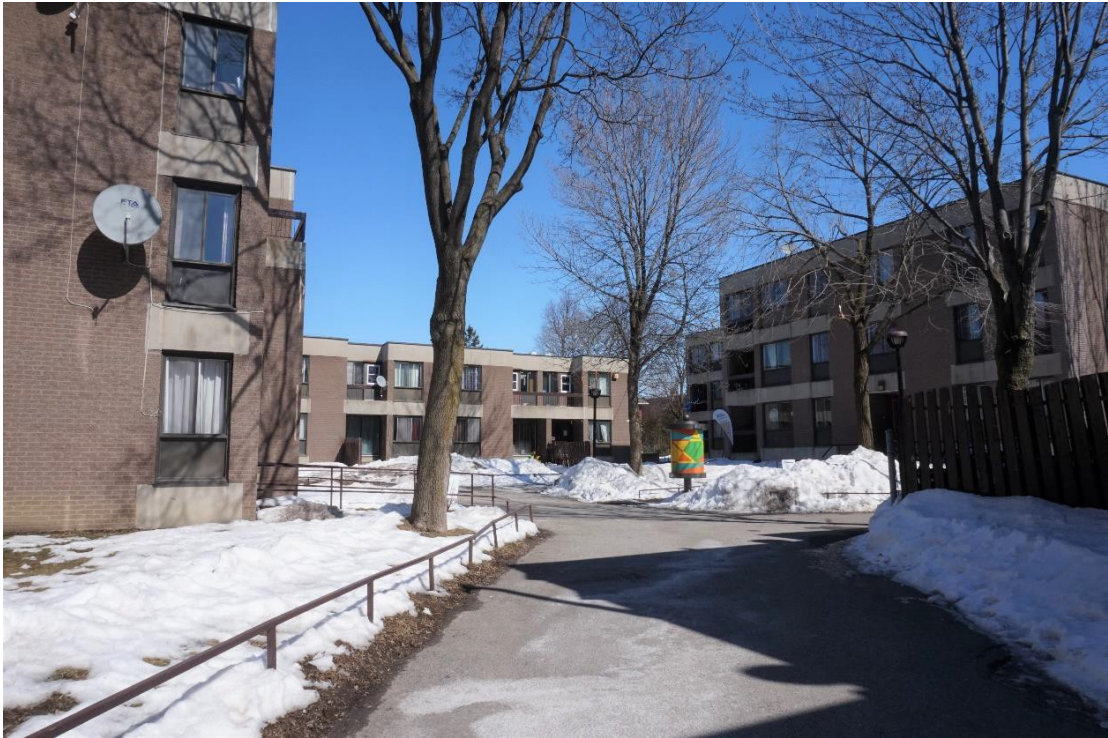
Figure 45 - L'ensemble HLM du Plan Robert avant sa démolition
