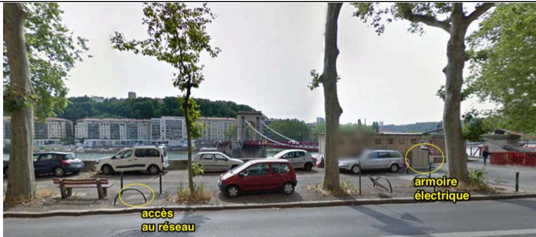
Site de mesure Quai Jayr, Lyon 9 e – Métropole de Lyon
