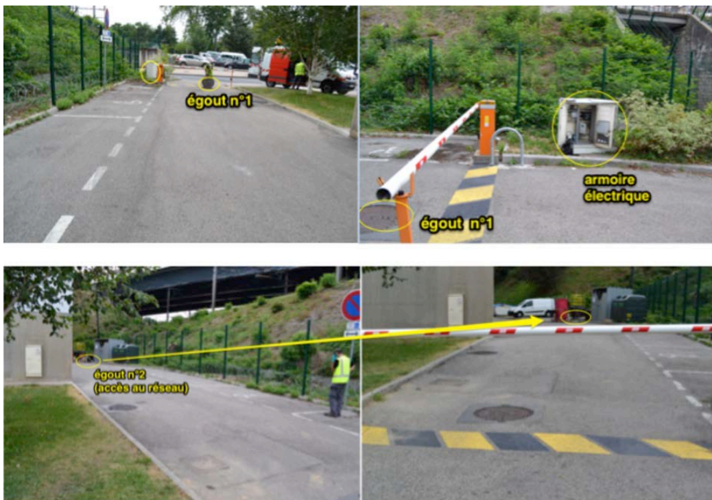
Emplacement de l'armoire électrique et du point d'accès au réseau
