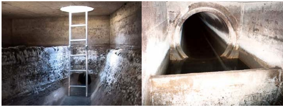
déversoir à seuil haut (à droite) ; déversoir à seuil frontal (à gauche)
