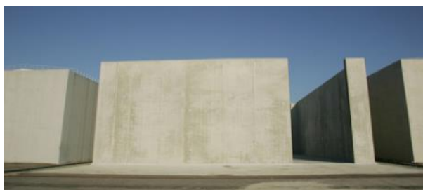
Alvéoles de stockage du CSA (P. Maurein, 2007)
