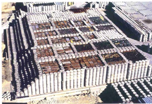
Stockage en tumulus de deuxième génération (1988), (Source, Mémoire Détaillée CSM, ANDRA 2008)
