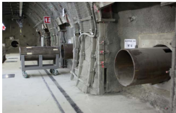
Alvéole HA n°4, Laboratoire souterrain
