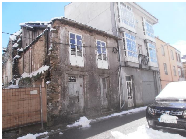
Figure 27 Exemple de logements vacants largement présents dans le bourg, A Fonsagrada, février 2016 (Photographie : Brouard-Sala Q.)
