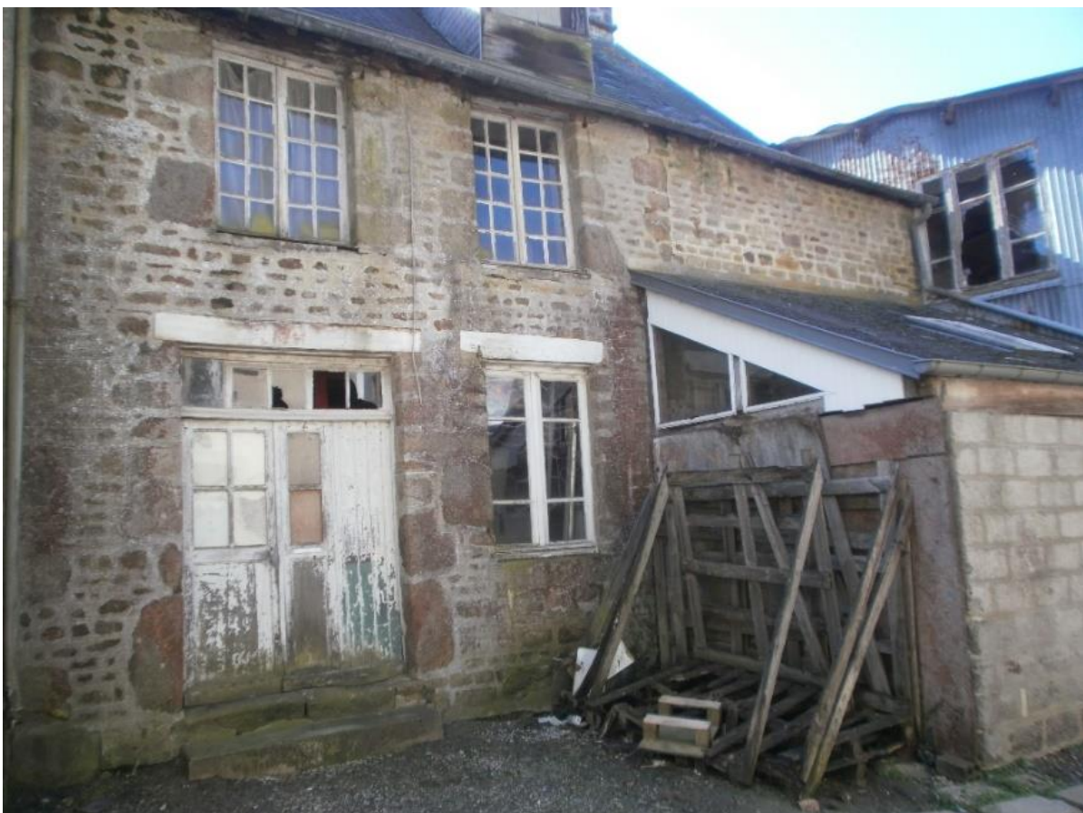
Figure 82 Maison vacante présentant des marques de vétusté, Le Teilleul, avril 2015 (Auteur : Brouard-Sala Q.)
