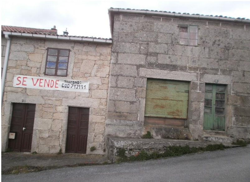
Figure 97 Maisons traditionnelles vacantes avec différentes portes d'entrées et une porte de commerce vacante, avril 2016, Monterroso (Photographie : Brouard-Sala Q.)
