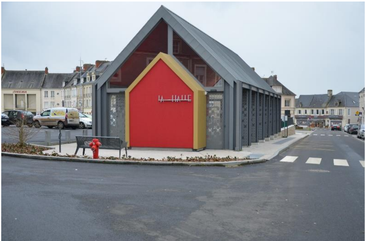
Figure 153 Halle multifonctions, Trévières, janvier 2021 (Photographie : Brouard P.)
