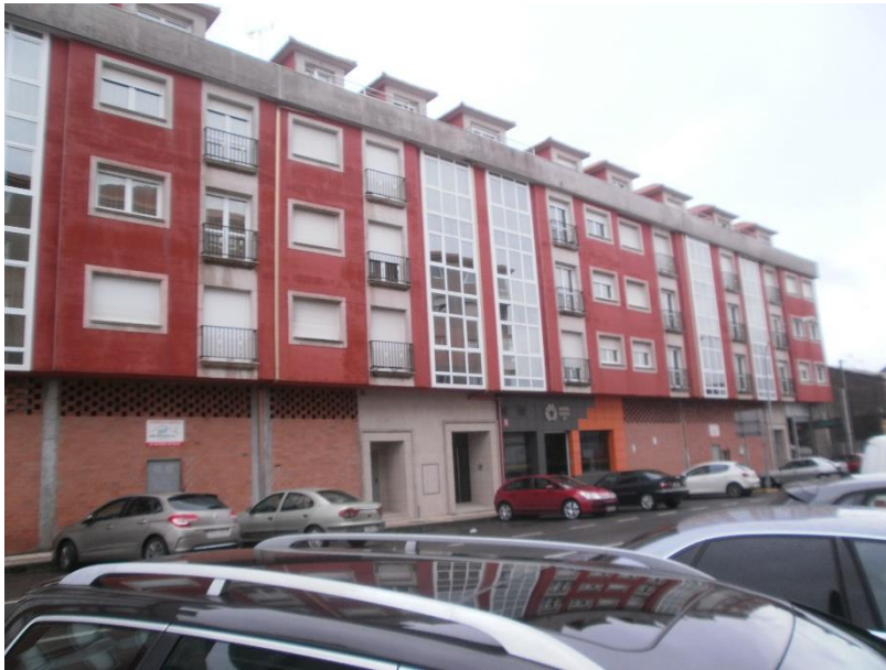
Figure 98 Immeuble avec des locaux commerciaux toujours inoccupés, février 2017, Santa Comba (Photographie : Brouard-Sala Q.)
