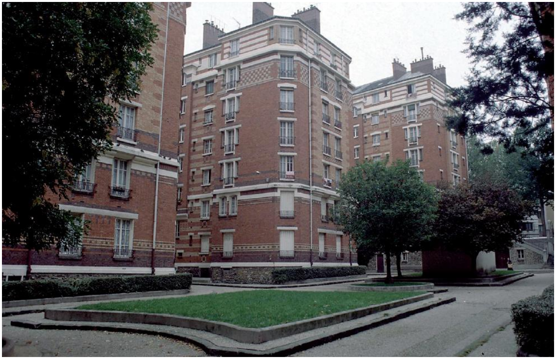
Figure 53. Immeuble de logement type H.B.M., 1924-1930, C. Heubès architecte, avenue Simon Bolivar, 19 e arrondissement, photo : D. Serero
