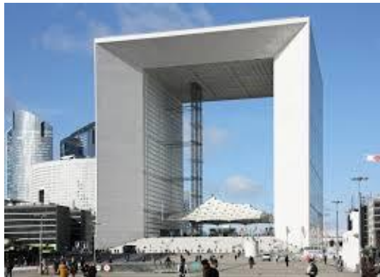
Figure 151 Etude complémentaire d'un bâtiment de très grande échelle dans un espace dégagé (Esplanade La Défense) (H=110m)
