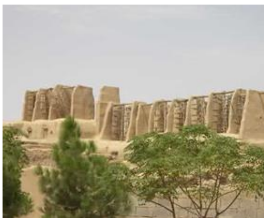
Figure 2. Les moulins à vent en terre crue de la ville de Nashtifan à l'est de l'Iran 6
