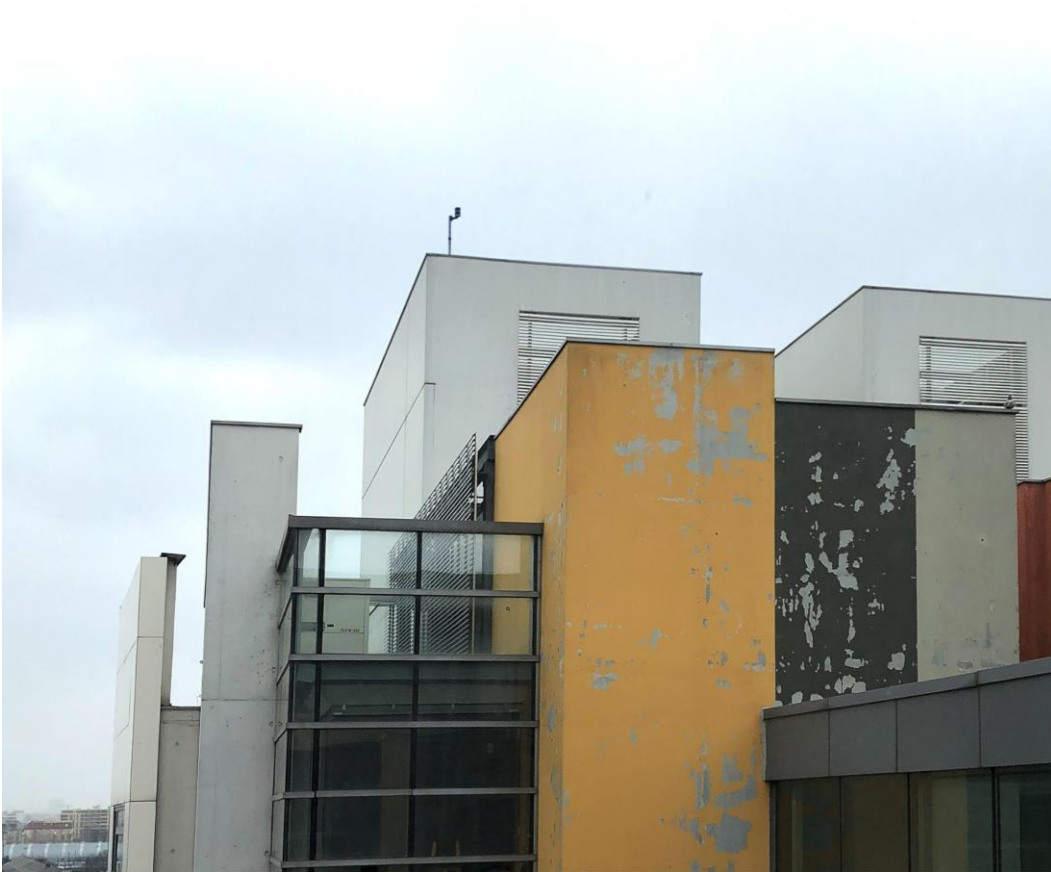
Figure 203. Vue du dispositif inséré sur le toit du bâtiment (Paris 75013)
