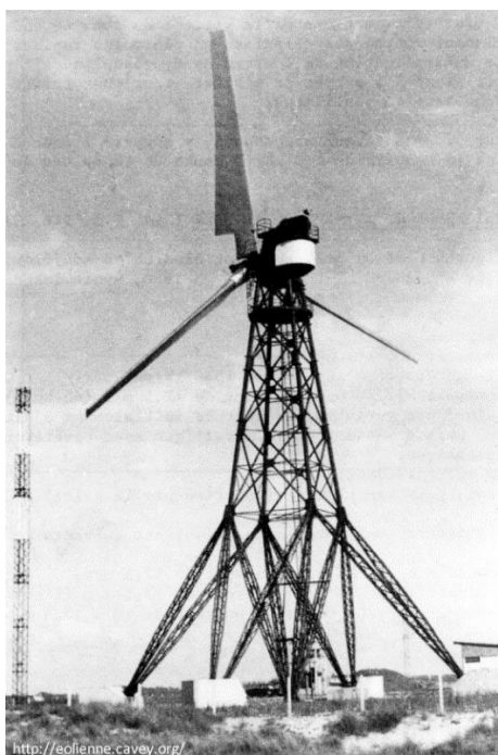
Figure 18. Machine de 35 m, 1 000 kW, Aérogénérateurs Neyrpic de Saint-Rémy-des-Landes. (Source : http://eolienne.cavey.org/communs )
