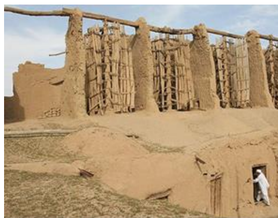
Figure 3. Les pales verticales des moulins à vent en terre crue remontent en partie contre le vent et limite la vitesse du dispositif, src : National Geographic, photo Reza Azizfarkhani
