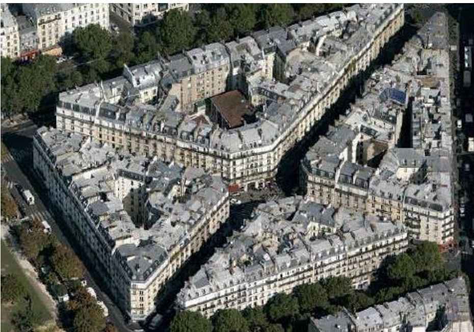
Figure 50. Rue de Dunkerque et rue de Guérande, 9e arrondissement. Immeubles de rapport, opération de lotissement, Source : Geoportail.
