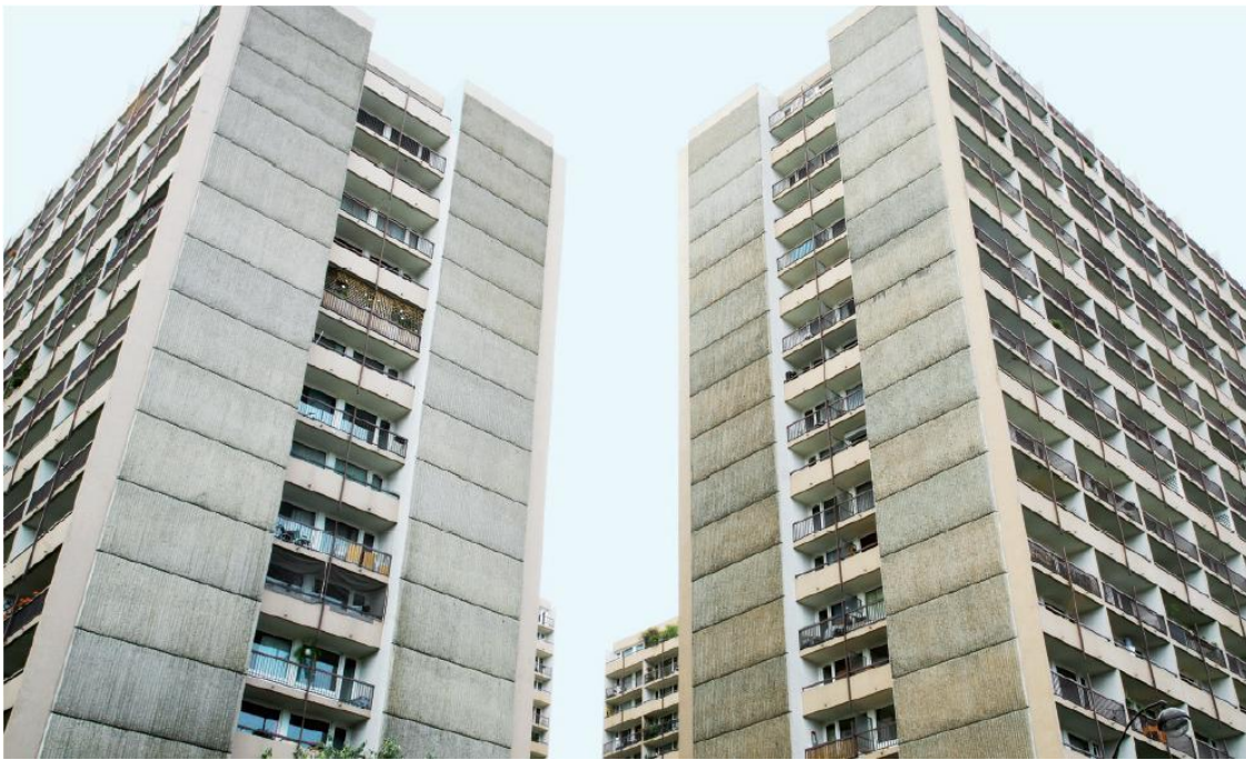
Figure 57. Immeuble de logement, rue Dunois et boulevard Vincent Auriol, XIIIe arrondissement.
