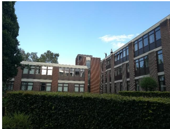
Figure 6.8 : Deux traceurs au bord du « roof gap ». Photo : Robin Lesné, 2019.
