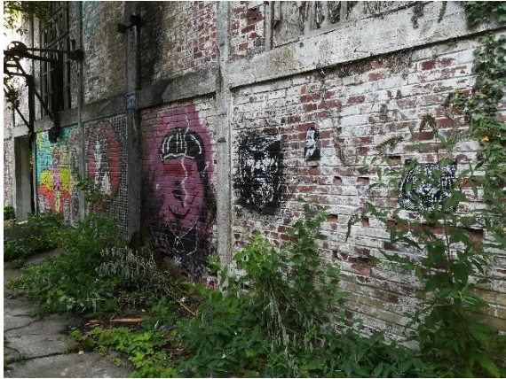
Figure 9.2 : Le site industriel abandonné, galerie de street art à ciel ouvert ? Photo : Robin Lesné, 2019.
