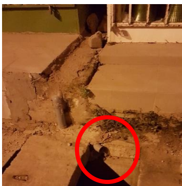
Photographie I-5 : Exemples d'incivilité à Ouagadougou par connexion de conduite d'évacuation d'eaux vannes directement dans un canal (a-) et dans la rue (b-)
