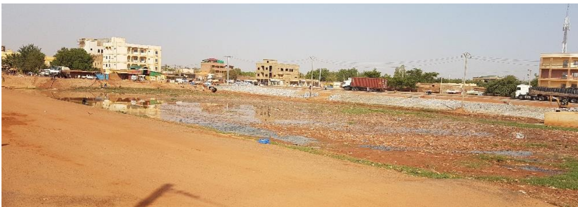
Photographie IV-3 : Exemple d'un bassin de rétention d'eau en fonctionnement jouxtant le boulevard des Tensoba à Ouagadougou
