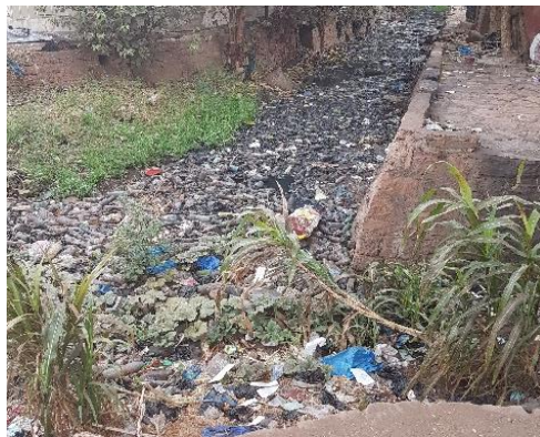
Photographie IV-7 : Les collecteurs de Ouagadougou réceptacles de déchets et débris de tout genre (source : auteur)
