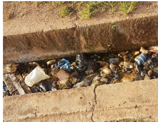
Photographie IV-6 : État de certains caniveaux à Bamako et Ouagadougou (source : auteur)
