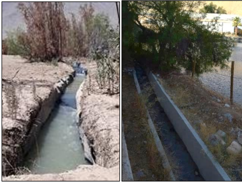
Photographie 46. Canal recouvert en béton armé à Pisco Elqui. Source : CNA, 2017.
