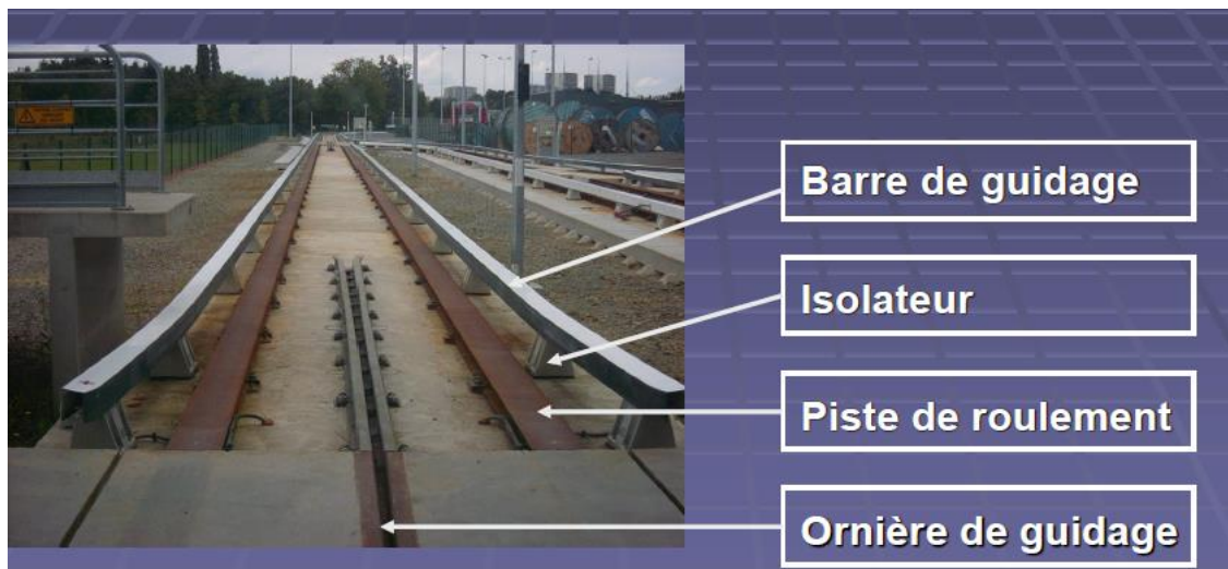
Figure 9 : Description des voies VAL
