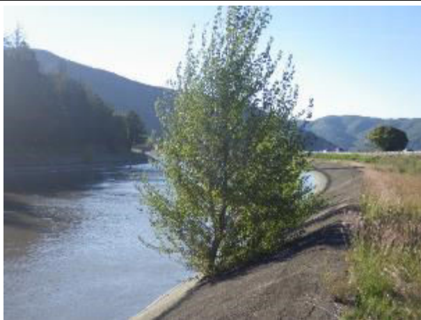
Photo I. 1 : Canal dont le bajoyer est constitué d'un revêtement rigide bitumineux (Photo : Macia J., 2015).
