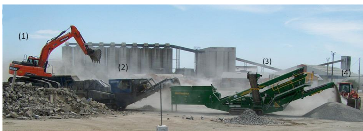
Figure 2-3 : Différentes étapes de la production des GR de Planète Recyclage : (1) Préparation par broyage des blocs de béton armé et déferrage à l'aide d'une pince de type BRH, (2) concassage, (3) criblage et (4) stockage (source : Recyment).
