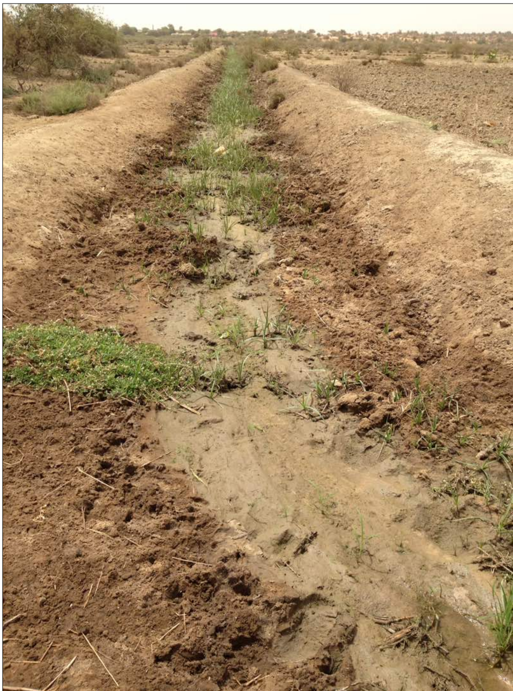
PHOTO 6.7 – « Canal de drainage » dans un PIP - Cliché : DIOUF O. 2018
