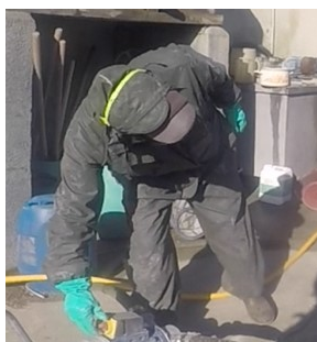
Illustration 96 : Mise en route de la pompe.
