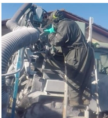
Illustration 88 : Vérification de la pression de pulvérisation.
