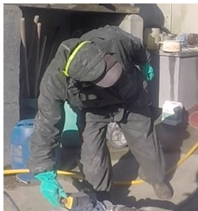
Illustration 96 : Mise en route de la pompe.
