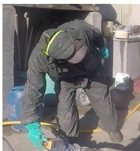
Illustration 96 : Mise en route de la pompe.
